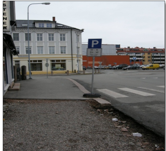
Manglende avsperring av arbeidssted.
