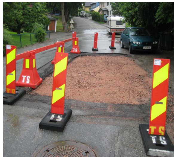
Sikring av gravested.
