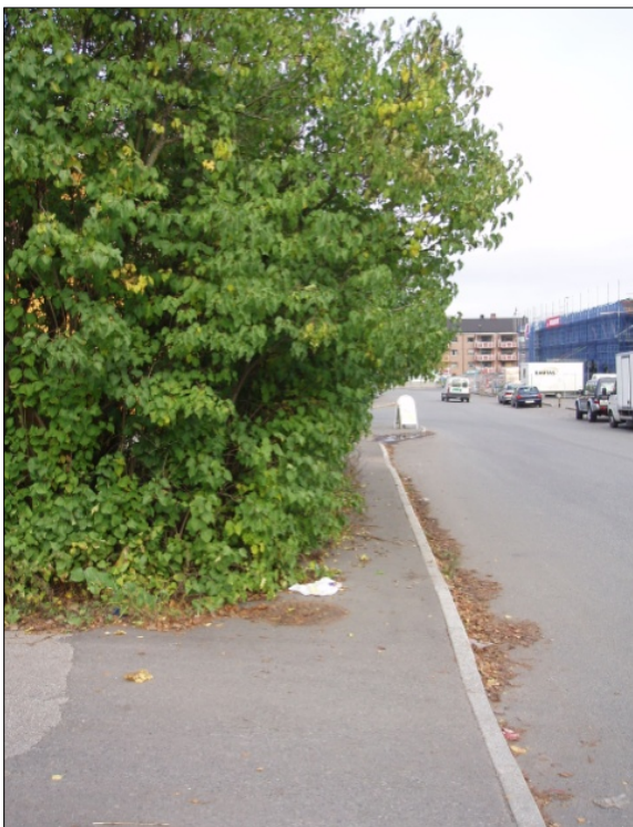
Manglende nedklipping av privat vegetasjon medfører sikt- og fremkommelighetsproblem
