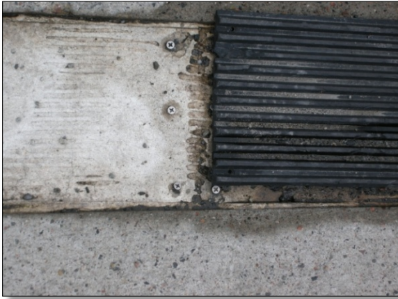
Skadd ledelinje i betongdekke.
