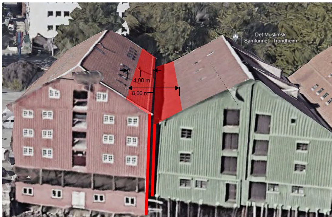
Figur 22: Illustrasjon av brannskille tilnærmet EI 60.
