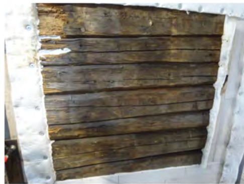
Foto 15 Branneksponert side av tømmervegg E før test. Røteskade i øvre venstre hjørne dekket med brannfugemasse.
