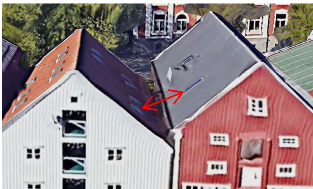
Figur 16: Illustrasjon mulig brannspredningspunkt mellom vinduer.
