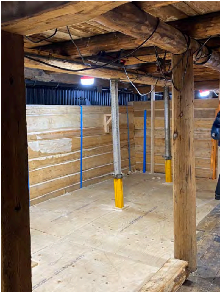
Ny yttervegger i tømmer i Kjøpmannsgata 55
