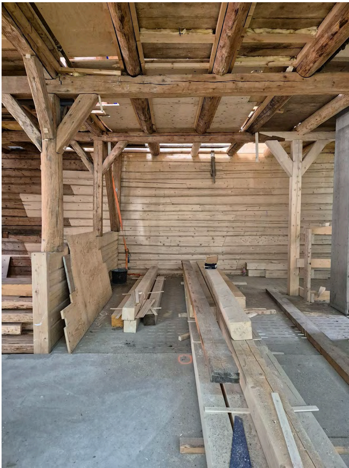
Nytt og gammelt laft i yttervegger i Kjøpmannsgata 15
