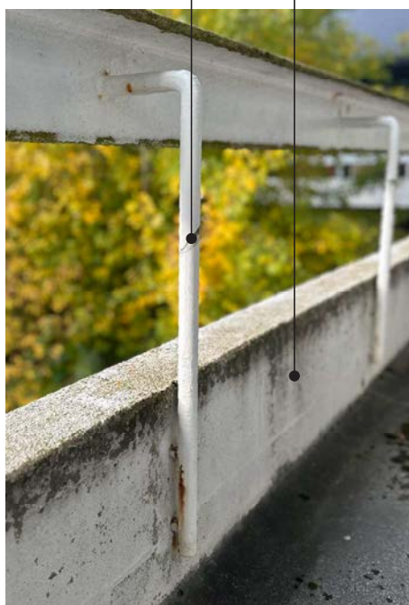
Rekkverk og balustre i metall, males hvit
