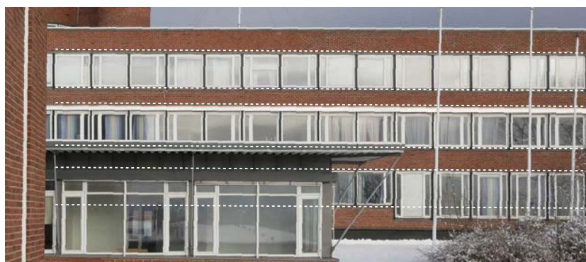
horisontale vindusbånd adskilt av teglforblending som markerer etasjenivåer
