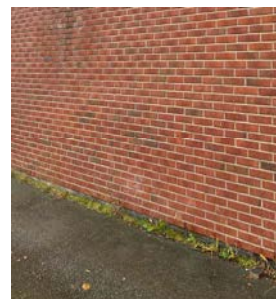
ringmur av eksponert betong i flukt med teglen, men knapt synlig (bygg D)
