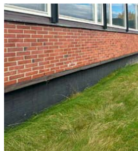
ringmur av betongtrukket bak teglforblendingen og malt sort (bygg B)
