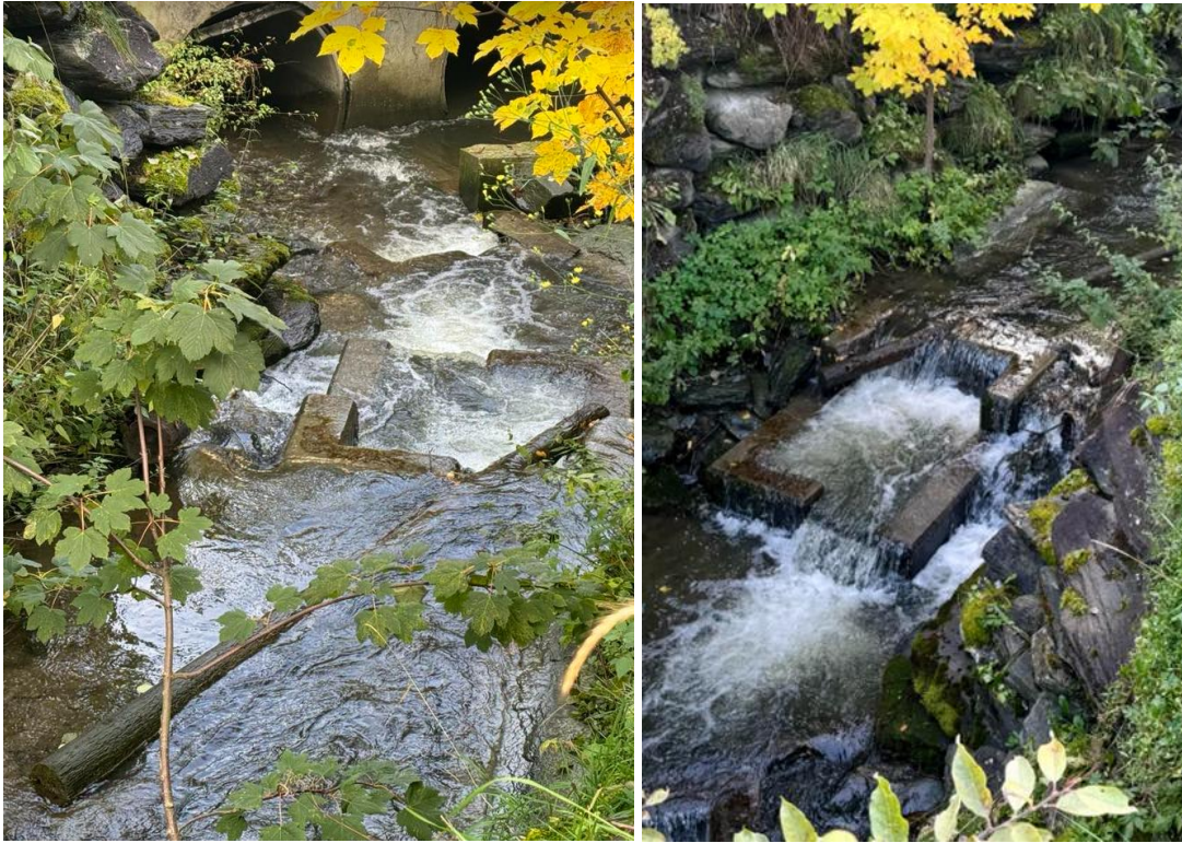
Figur 84. En tømmerstokk har kilt seg fast i fisketrappa I Sjøskogbekken i 2024. Foto ovenfra og ned (t.v.) og nedenfra og opp (t.h.).
