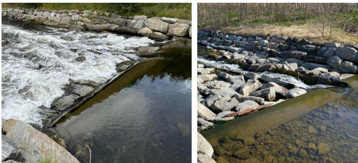
Figur 87. Terskler i nedre del av Vikelva på normal, vandringsstoppende vannføring for fisk (t.v. mai 2024) og høy fiskeførende elv (t.h. september 2024).
