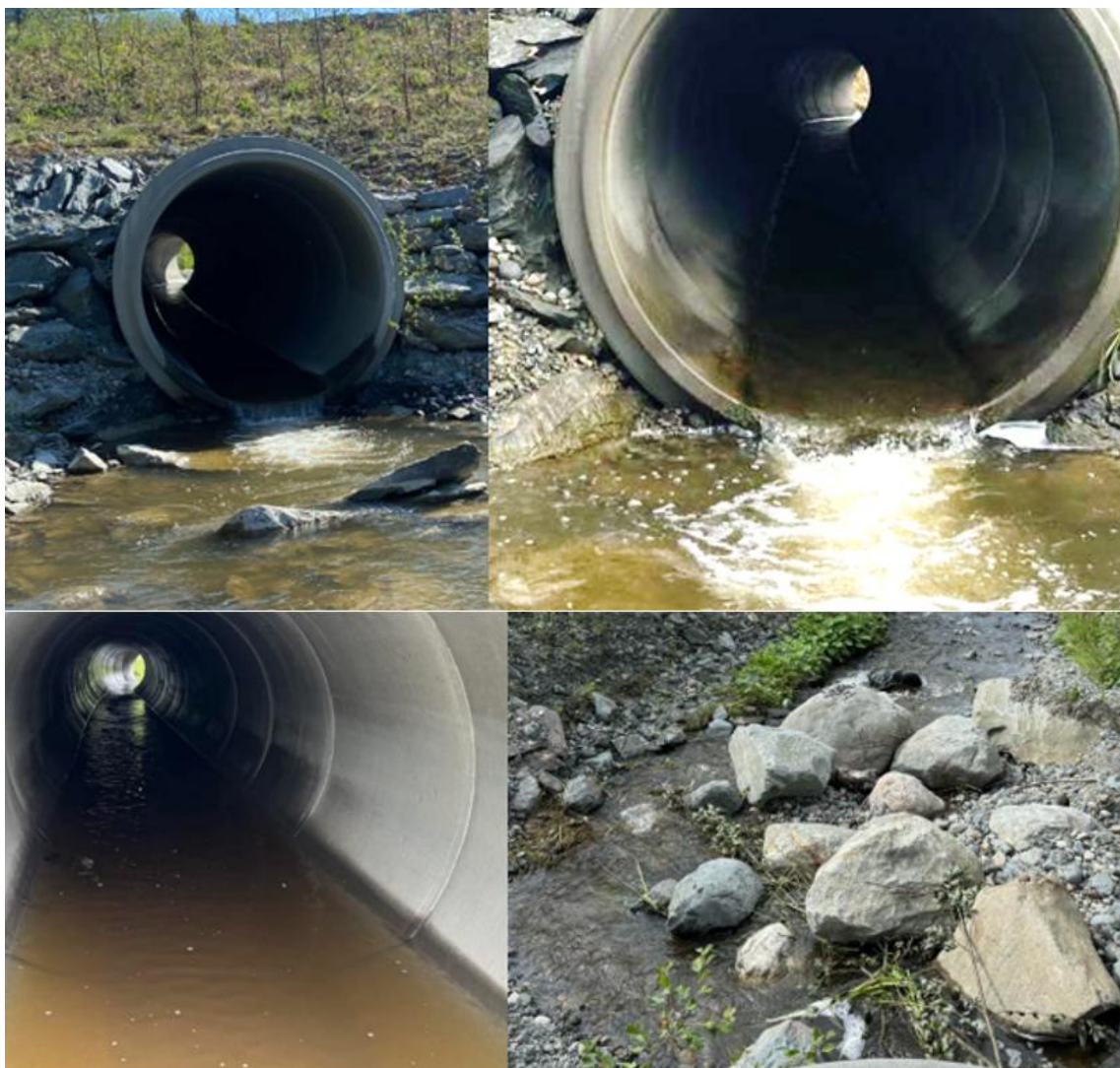
Figur 55. Øverst: Foto fra 2023. Kulvert i Solemsbekken før tiltak. Nederst: Foto fra 2024. Kulvert i Solemsbekken etter tiltak.
