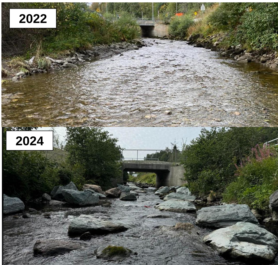
Figur 24. Utlekking av storstein/blokk i nedre del av Leirelva før samløp med Nidelva. Før (øverst) og etter (nederst) tiltak.
