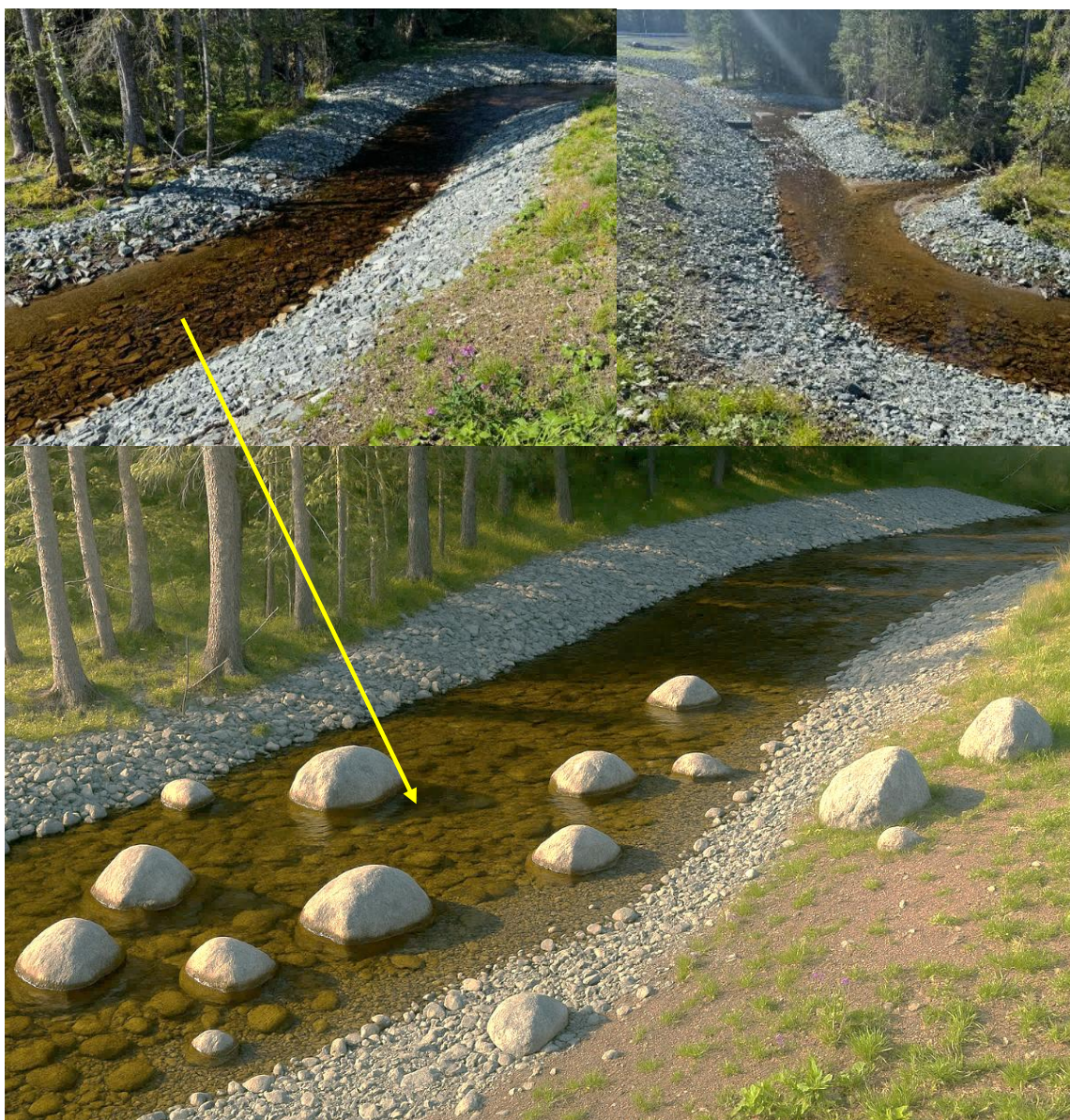
Figur 61. Øverst: Tidligere naturlige bekkestrekninger er nylig gjort om til sterile bekkekanaler dominert av grov skuttstein i midtre del av Tullbekken. Foto fra 27. august 2024. Nederst: Bilde generert av Open AI 2025 (ChatGPT), basert på tekst (prompt) skrevet av Morten A. Bergan, NINA, og viser Vannforskriftens minimumskrav til tilstand slik NINA vurderer det.
