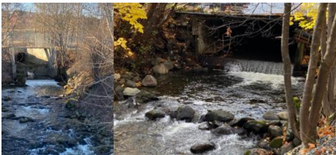
Figur 86. Lukking i kulvert under E6 (t.v.) og papirfabrikk (t.h.).
