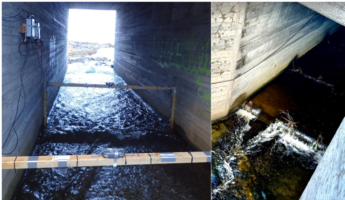
Figur 102. Kulvert under Bynesvegen før tiltak (foto fra 2015) og etter tiltak (i 2024).
