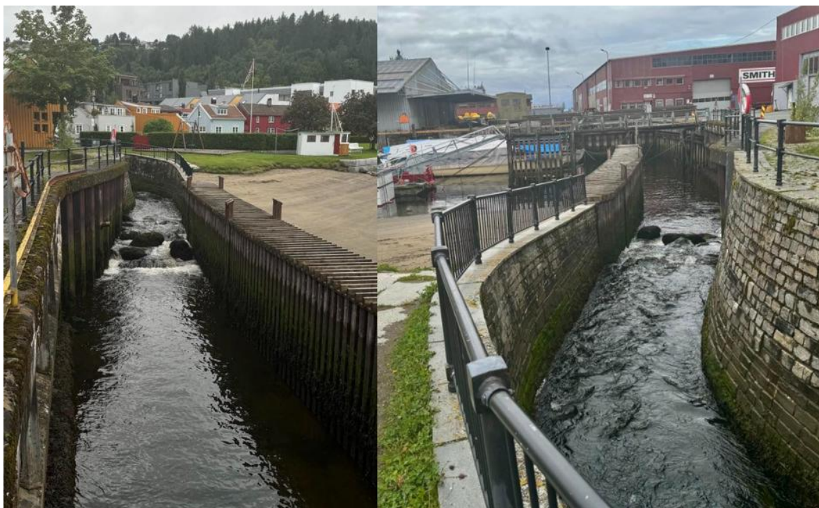
Figur 95. Ila-bekken er sterkt modifisert og kanalisert, men oppgangsforholdene for sjørørret i overgang sjø og bekk synes gode. Foto høsten 2024.
