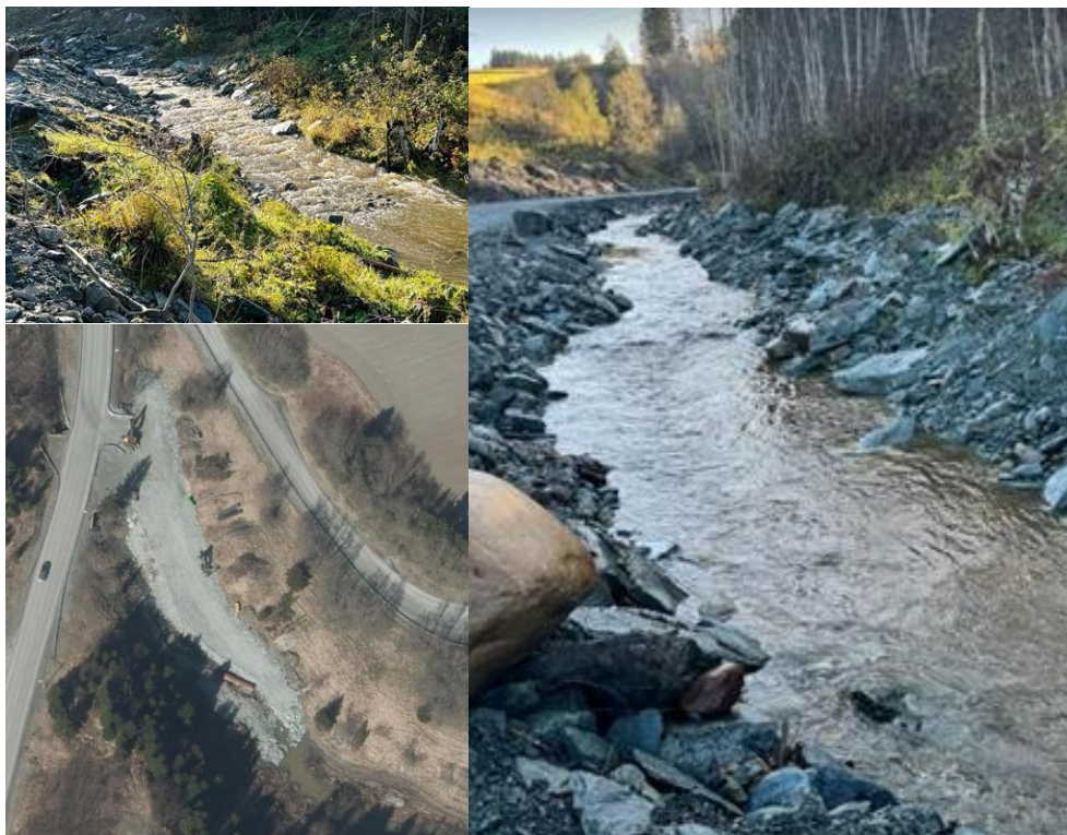
Figur 54. Anleggsarbeid i Solemsbekken oppstrøms Amundalsvegen i 2024. Flyfoto fra 2024 (nederst til venstre) og foto i felt i oktober 2024. Flyfoto: https://kart.finn.no/
