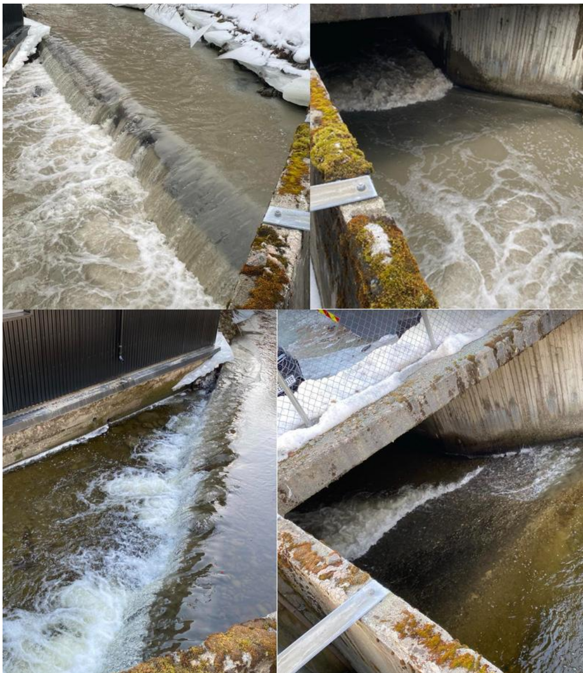
Figur 28. Vandringshindrende inngrep i vannveien i Leirelva i forbindelse med lukking under næringsområde og vei i midtre del av Leirelva. Foto på to ulike vannføringer våren 2024.
