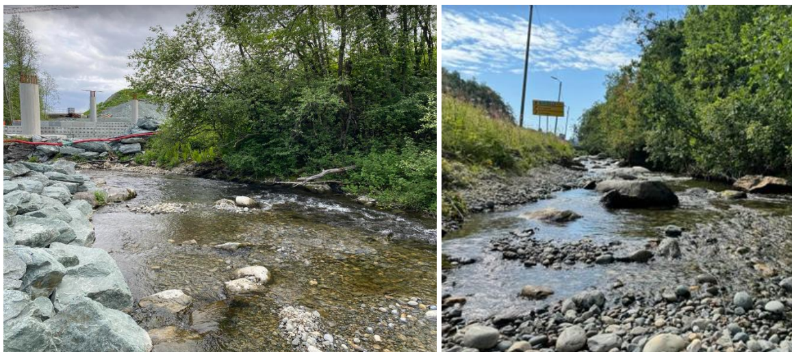
Figur 16. Styrking av gytemuligheter i hele Leirelva etter tilførsel av 1600 m 3 gytesubstrat. Eksempler fra elvepartier i nedre del av anadrom strekning, som hadde størst underskudd av denne substratypen før restaurering.
