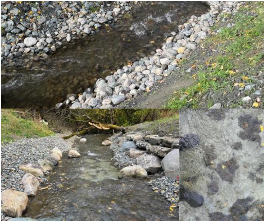
Figur 85. Restaurerte strekninger mangler storstein i bekkeløpet. Utlegging og plassering har bidratt til kanalisering på enkelte partier. Dette har dannet strykstrekninger med stor utspyling av mindre elvestein, slik at leire kommer fram i dagen (nederst).
