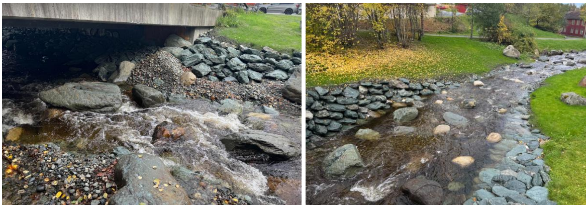
Figur 99. Det er tilført storstein og gytegrus i Ilabekken på nylig sikrede strekninger nedstrøms brukrysningen for Hanskemakerbakken/Bynesvegen. Foto høsten 2024.
