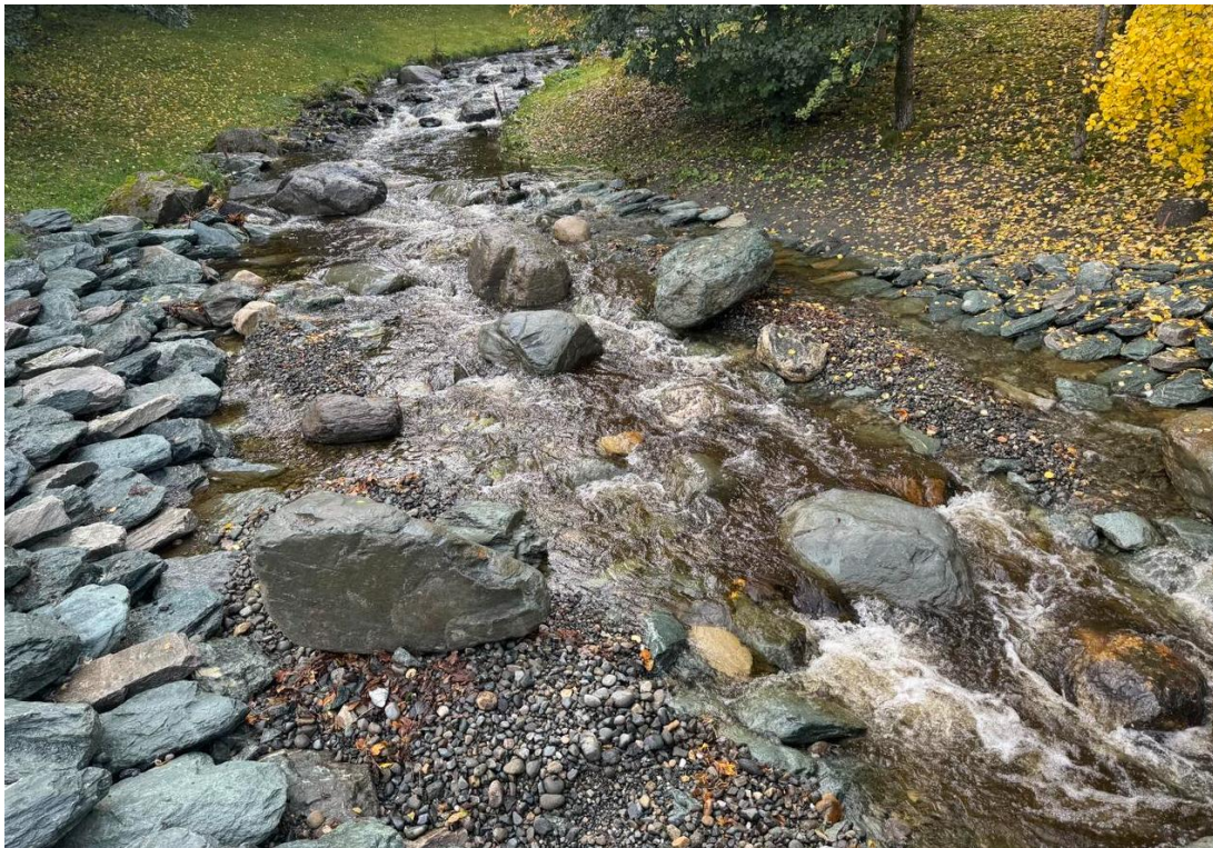
Figur 100. Det er utført utvidelse av bekkeløpet i forbindelse med sikring, og det er tilført storstein og gytegrus i etterkant av sikringsarbeidet, Foto høsten 2024, på strekninger oppstrøms brukryssningen for Hanskemakerbakken/Bynesvegen i Ilabekken.
