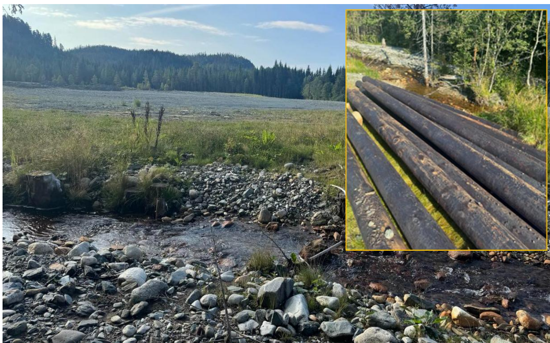
Figur 77. T.v: Arbeid med ny parkeringsplass har ødelagt Merkesbekken som gyte- og oppvekstområde for nidelvørret inntill videre. Innfelt: Trestokker med oljeholdig impregnering ligger opplagret tett inntill bekkeløpet.
