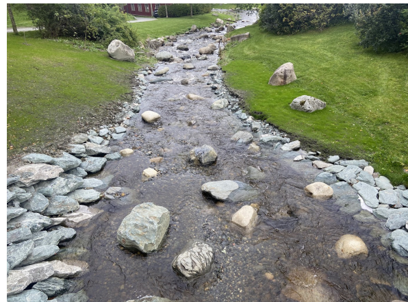
Figur 7.1.3. Utlegging av gytegrus og storstein i Ilabekken sommeren 2024 skal bidra til økt sjøørretproduksjon.
