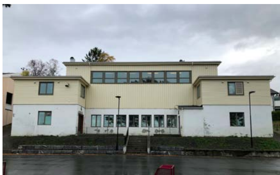
Gymnastikkbygget Ranheim skole antikvarisk klasse C
