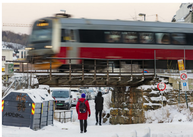
Undergang jernbanen ved Svartlamon
