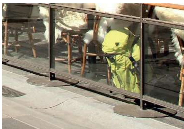
Bildet viser gunstig fot laget av stålplate.
