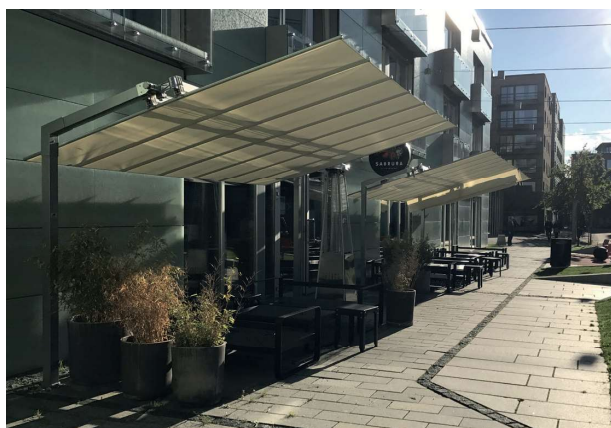
Bildet viser ensidig, frittstående markise inntil bygg. Markisen er i nøytrale farger, i tråd med oppfordringene i denne veilederen. Foto: Mari Basberg/Trondheim kommune
