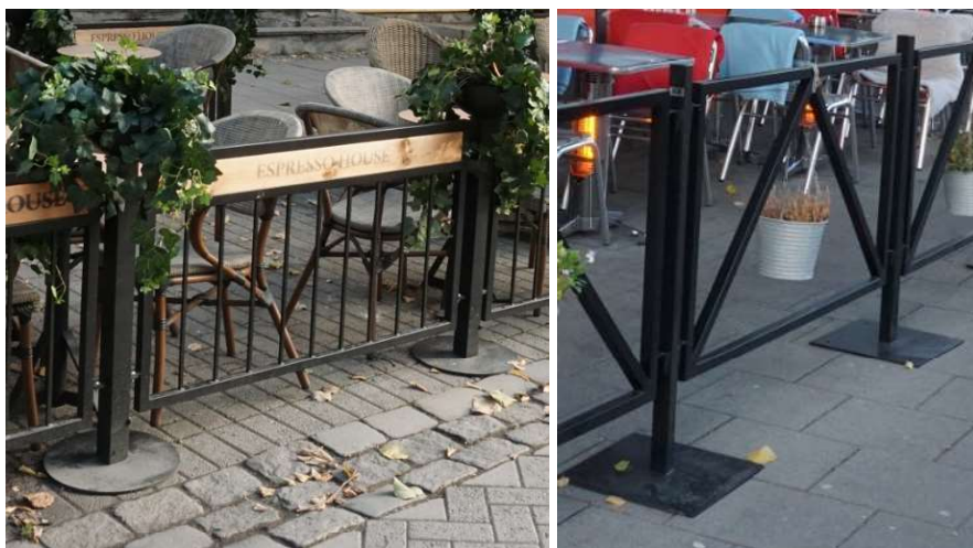
Eksempel på stødig fot til pullert som ikke trenger nedstøping. Foto: Trondheim kommune
