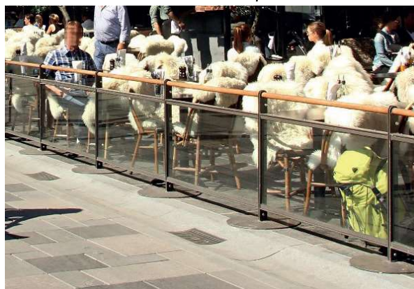
En avgrensning med topplist av tre, fremstår som en god løsning. Høyden på denne er 90 cm. Denne høyden føles behagelig for en gjennomsnittlig høy person som sitter.
