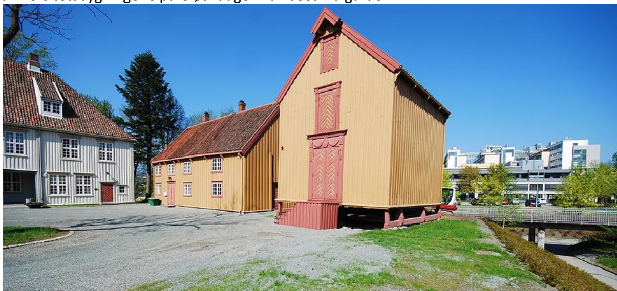
Lerkendal gård med Gløshaugen og gangveien under Leangenbanen. Foto: Bård Magnus Fauske, LINK arkitektur
