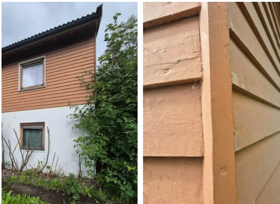
Liggende kledning med et vertikalt stilt hjørnebord.
