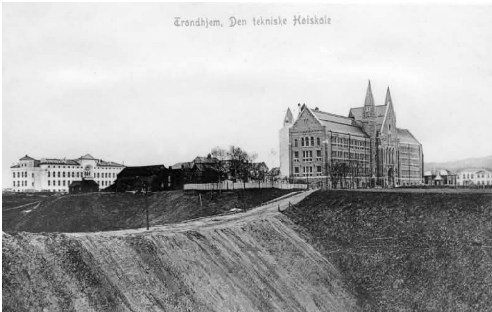
Store masser ble fylt i dalen før byggingen av Høgskolebrua. Bildet er hentet fra wikistrinda og tatt i 1910-12.
