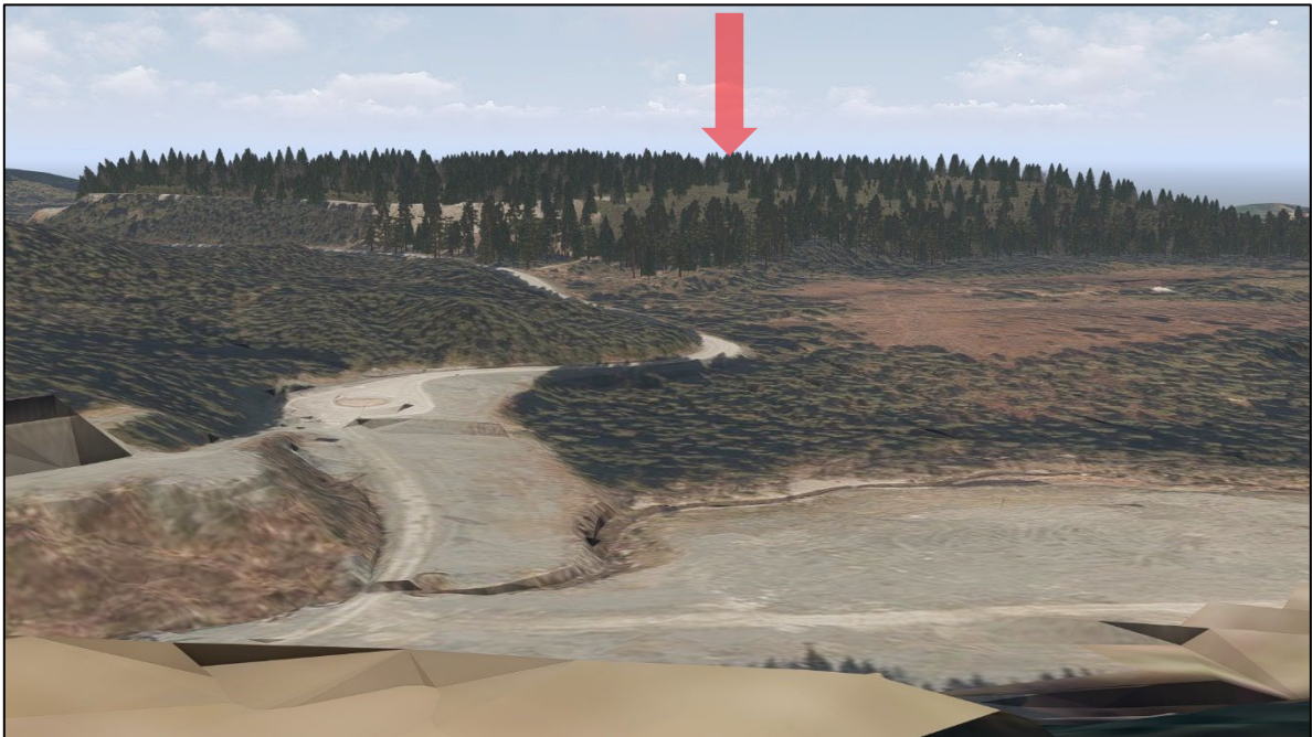
Figur 26. Ferdig oppfylt og revegetert deponi sett fra Litjvollen. Rød pil markerer deponiet.
