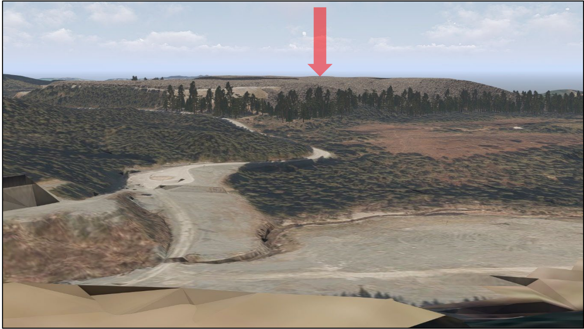
Figur 25. Ferdig, ikke revegetert, deponi sett fra Litjvollen. Rød pil markerer deponiet.
