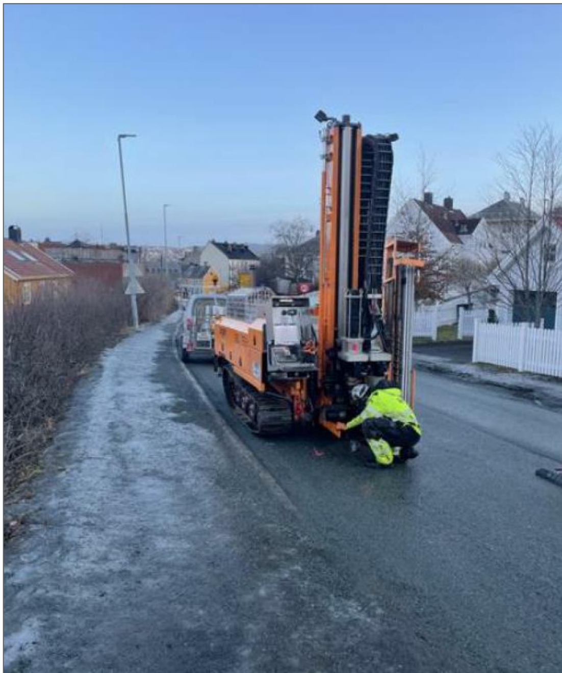
Figur 5-1: Bilde av borearbeider med borerigg i Roald Amundssens vei (Lingen grunnboring).
