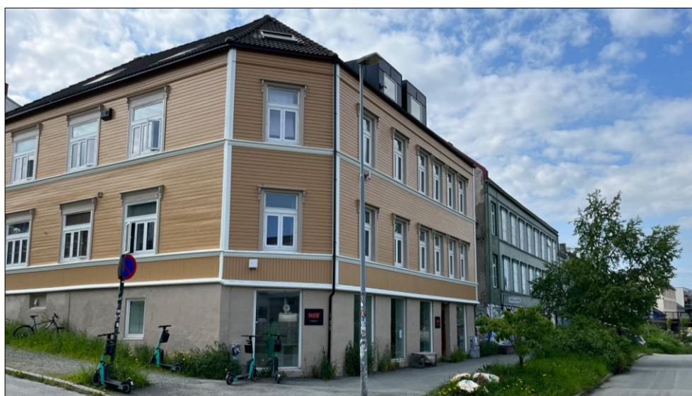
Figur 5-21: Lademoen stasjon, sett i retning nord. (Kilde: COWI AS).
