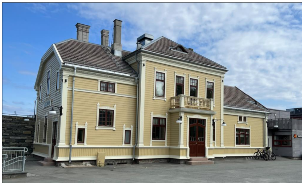
Figur 5-20: Lademoen stasjon, sett i retning nord. (Kilde: COWI AS).
