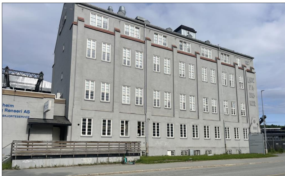
Figur 5-1: Jarleveien 4 sett i retning nord. (Kilde: COWI AS).
