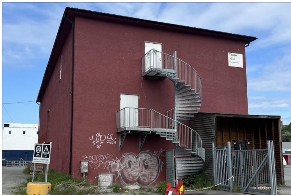
Figur 5-14: Driftsavdelingen sett i retning nord. (Kilde: COWI AS).
