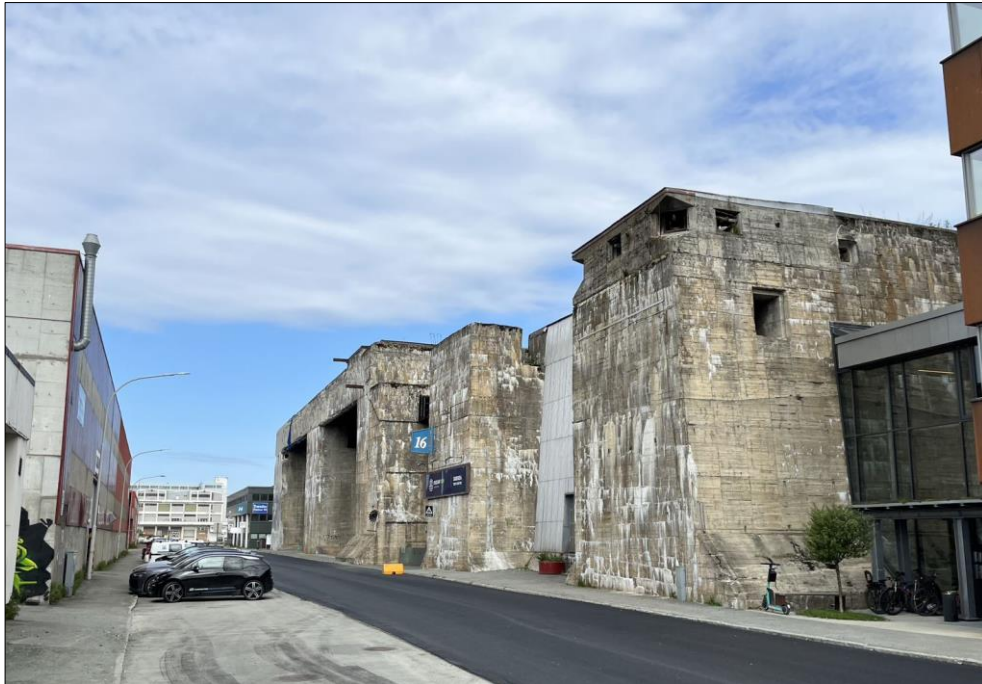
Figur 5-9: Dora 2 i retning nord. (Kilde: COWI AS).
