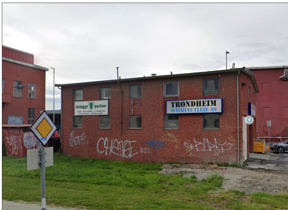
Figur 5-12: Kjelhuset sett i retning nord. (Kilde: COWI AS).
