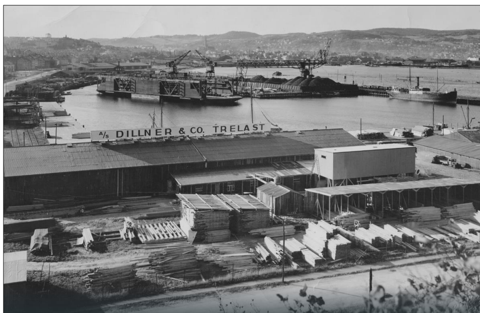
Figur 4-3: Trondheim Mekaniske Verksted 1938. med flytedokken i bakgrunn fotografert i 1938. (Foto: Trondheim Byarkiv).
