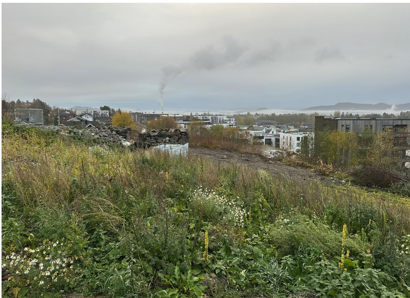
Fra befaring. Gården er revet og bare grunnmuren står igjen. Utsikt mot øst.
