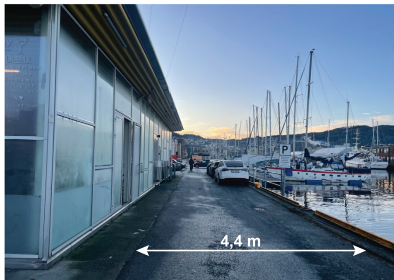
Foto fra dagens situasjon tatt omtrent der foreslått bro møter kaikanten ved Fiskehallen viser en bredde på 4,4 meter ferdselsareal mellom eksisterende fiskehall og kai. Det viser også dagens parkering regulert av Trondheim Havn. Ny bro vil øke ferdselen også vestover langs Kanalen. (Foto: Saksbehandler)
