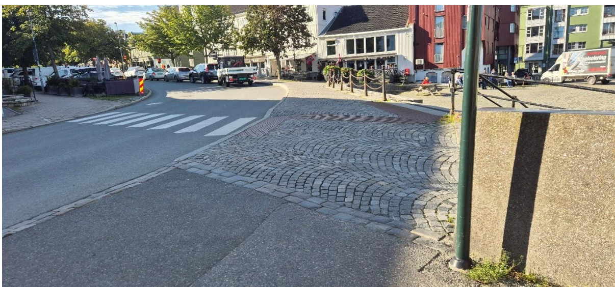
Figur 30: Fortau forbi amfibenkene i Ravnkloa på nordvestsiden av overgangen mellom Munkegata og Fjordgata (Foto: Asplan Viak 27.08.2025)
