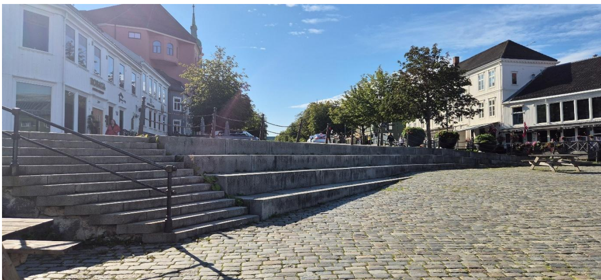
Figur 31: Trapp mellom plassen/amfiet i Ravnkloa og fortauet i Munkegata/Fjordgata (Foto: Asplan Viak 27.08.2025)
