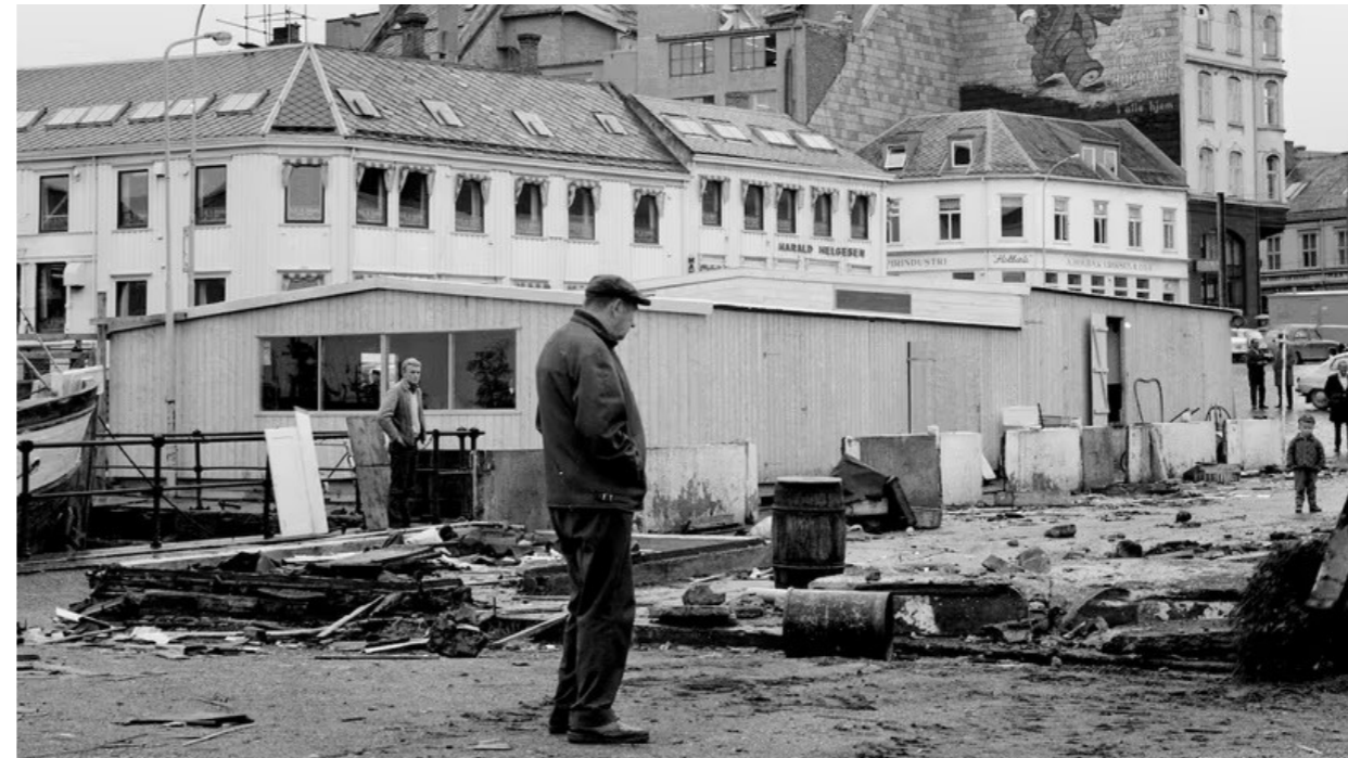
Etter en brann i xx ble det oppført nok en fiskhall , denne gang i betong.
