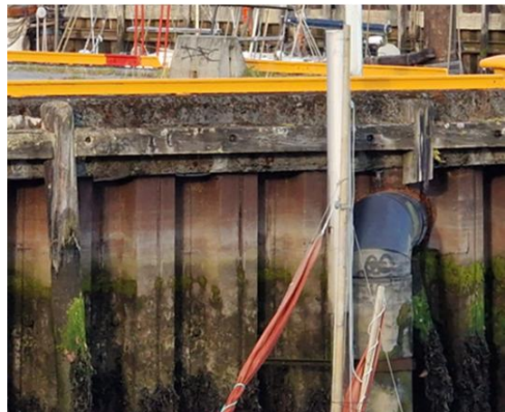
Bilde fra Ravnkloa med fjernvarmerør
