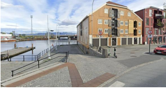
Dagens situasjon langs Smithbrygga (google)
