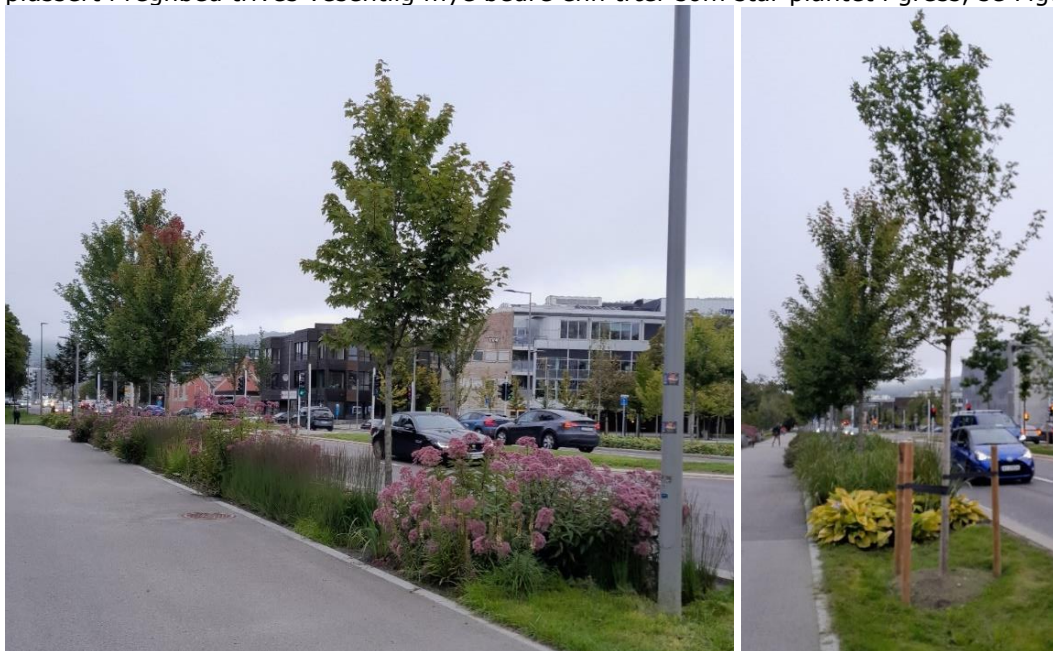
Figur 10 Eksempel regnbed med trær, Bjørnstjerne Bjørnsons gate (Drammen). Foto: FREK/Rambøll, aug-23
