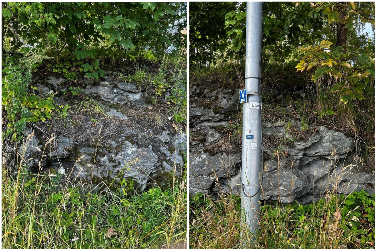
Figur 5: Bergmassen i skjæringen er tydelig preget av foliasjonsprekker som varierer lokalt i oppsprekkingsgrad.
