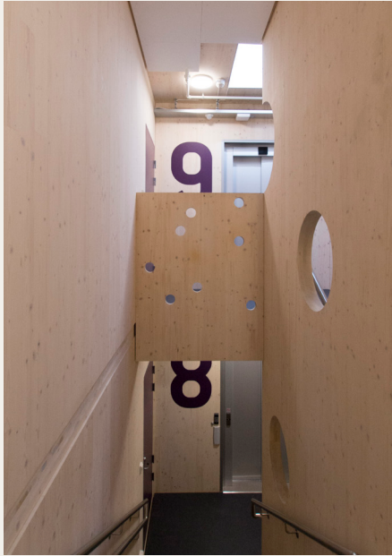
Massivtreets muligheter er utnyttet med morsomme løsninger i trapperommet.
