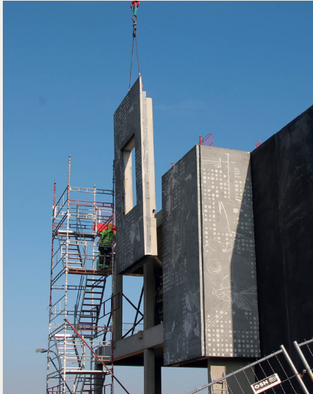
Elementer med grafisk betong heises på plass.
