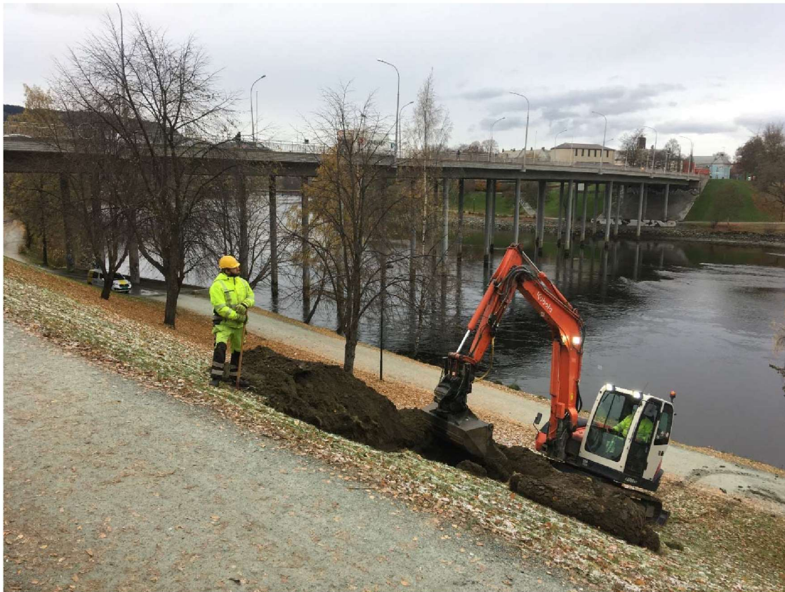
Figur 1 Graving av sjakt 1. Foto: Synne Husby Rostad/Trøndelag fylkeskommune
