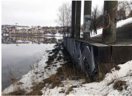
Forstøtningsmur sikrer søylepunkt. Søndre brukar
