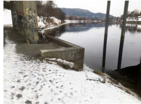
Forstøtningsmur sikrer søylepunkt. Søndre brukar
