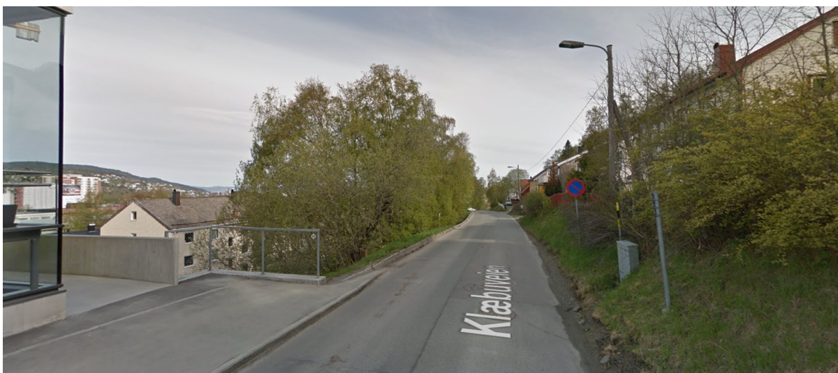
Figur 6 I dag avsluttes fortau brått ved Øystein Møylas veg 14, 16 og 18
