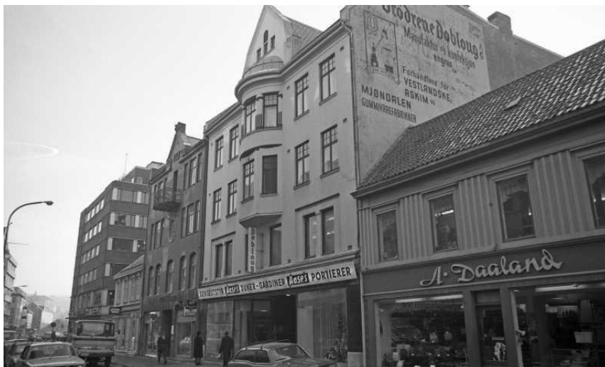
Figur 4-17 Thomas Angells gate, bygget i 1913 i jugendstil. Foto: Trondheim kommune
