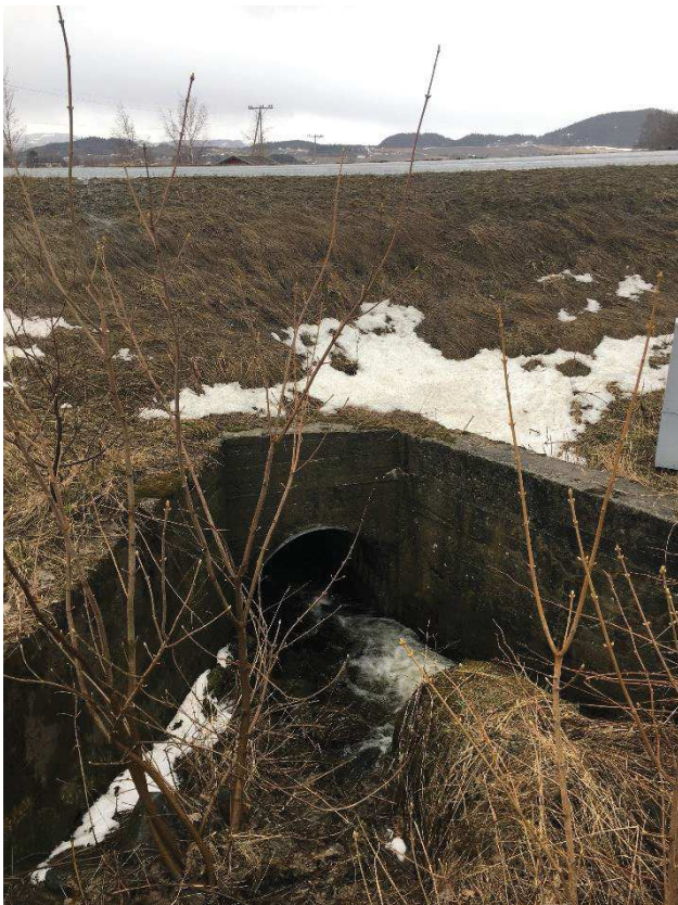
Bilde 3. Utløp Ø800 mm bekkelukking / Innløp Ø1200 mm stikkrenne
