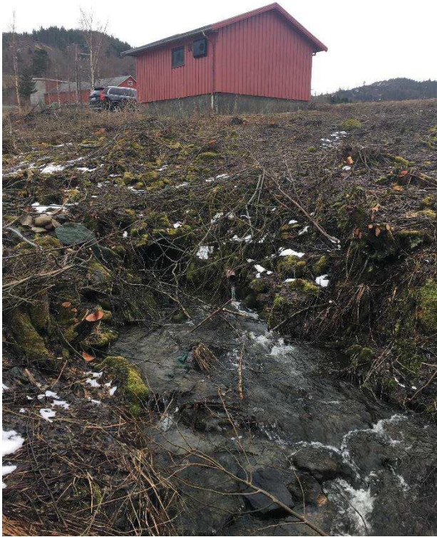
Bilde 4. Utløp Ø1000 mm stikkrenne
