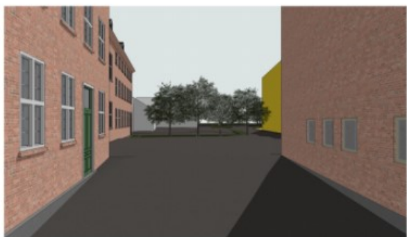
03 Mellom Hørstoft bygget og Aale bygget
