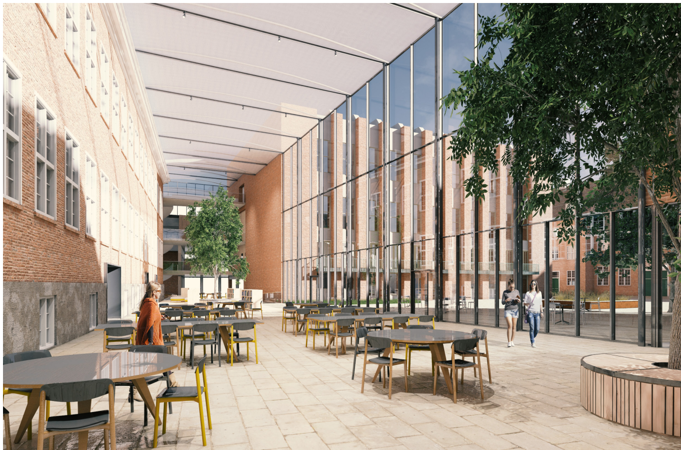
Fra innsiden av mellombygget. Hovedfasadene på Moe II, Aulabygget og Harsdorffbygningen er alle synlige
