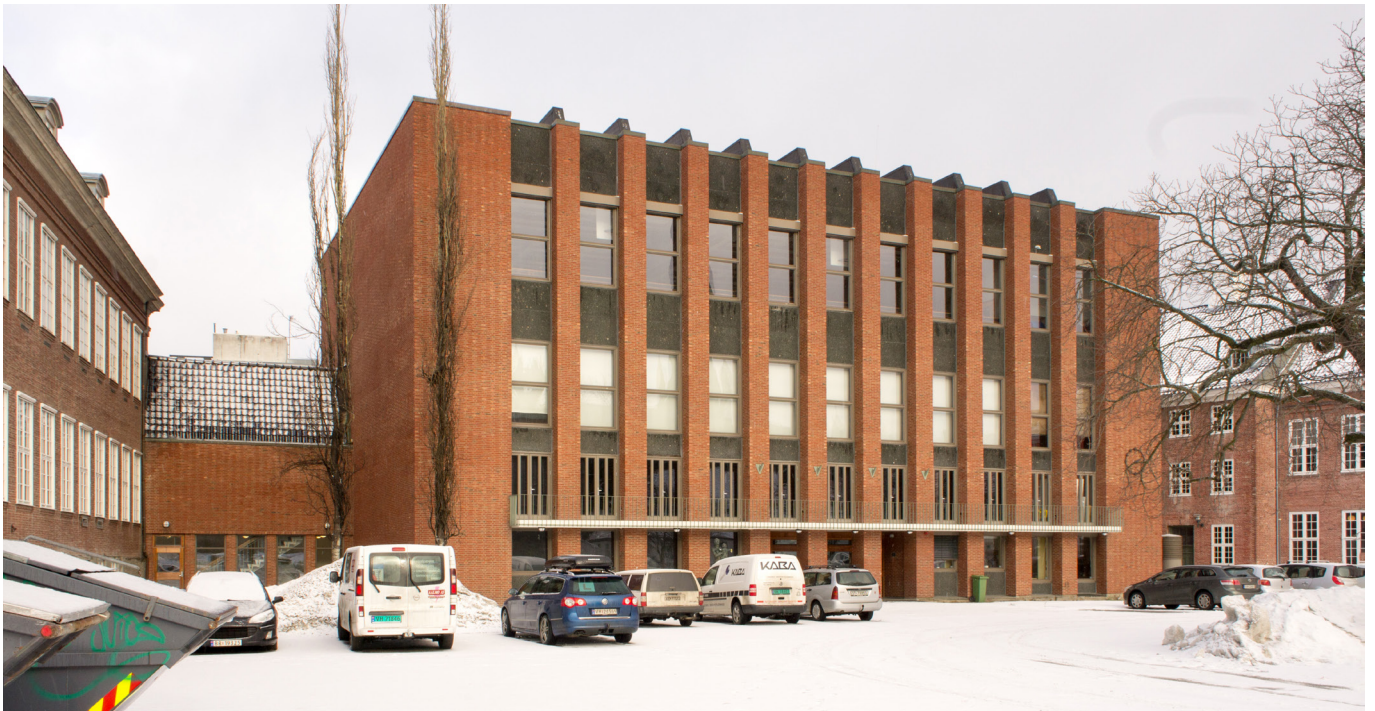
Aulabyggets sørfasade sett fra gårdsrommet
