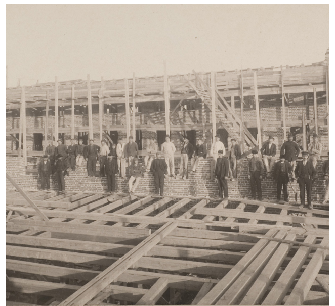
Byggearbeider ved Moe I, ca. 1922
