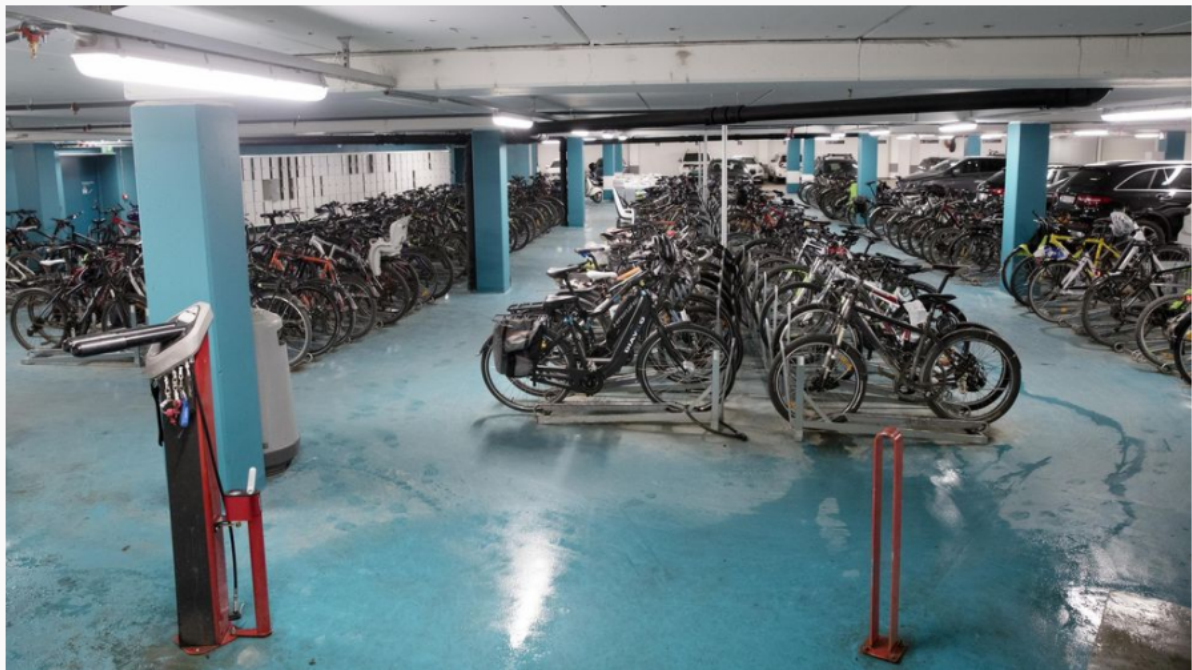
Figur 5. Attraktiv sykkelparkering med enkel og rask tilgang til utstyr for service og vask av sykkel og garderobefasiliteter i Abels Hus i Trondheim 6
