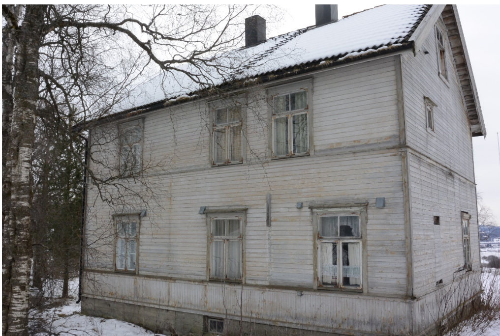
Foto av verneverdig bygning, nordfasade. Kilde: Norconsult.
