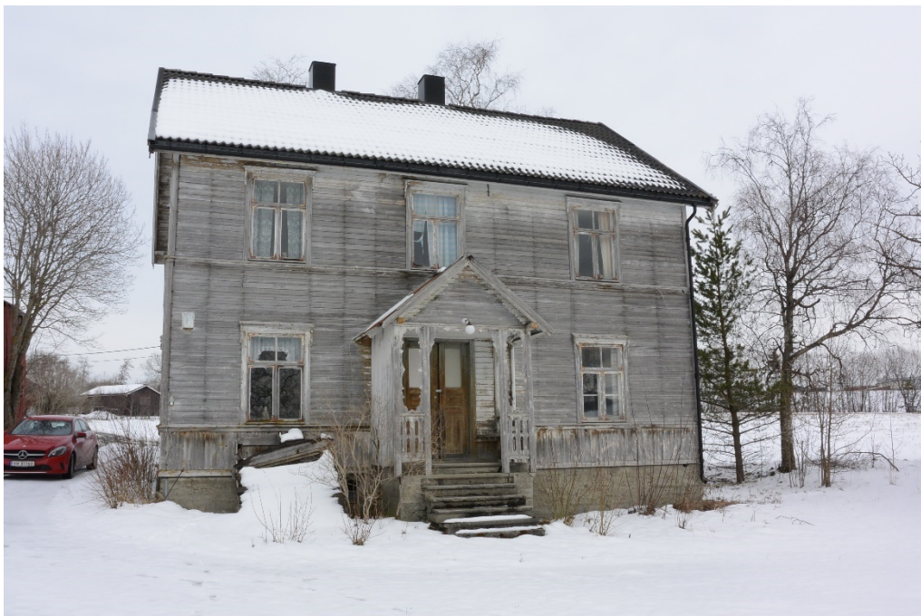
Foto av verneverdig bygning, sørfasade. Kilde: Norconsult.
