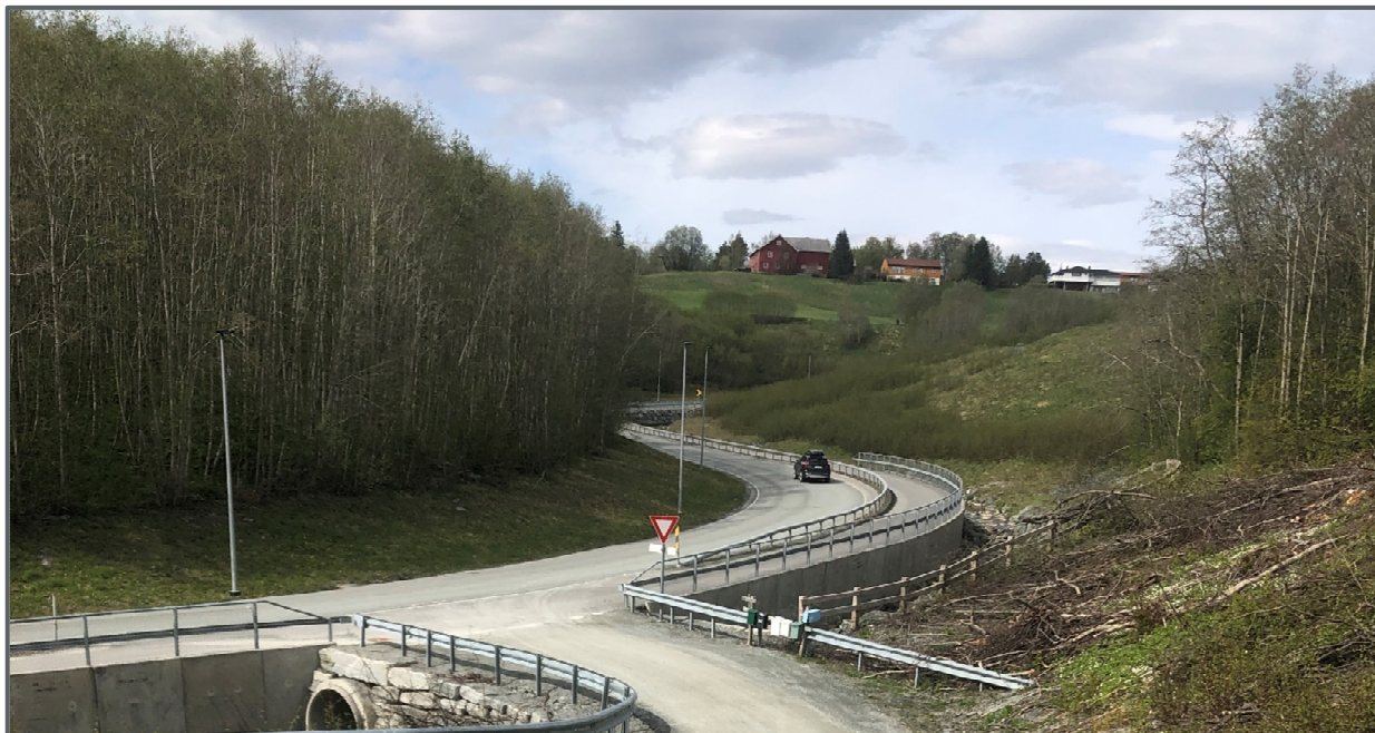
Figur 3: Utbedret avkjørsel mot Heimdalsvegen.
