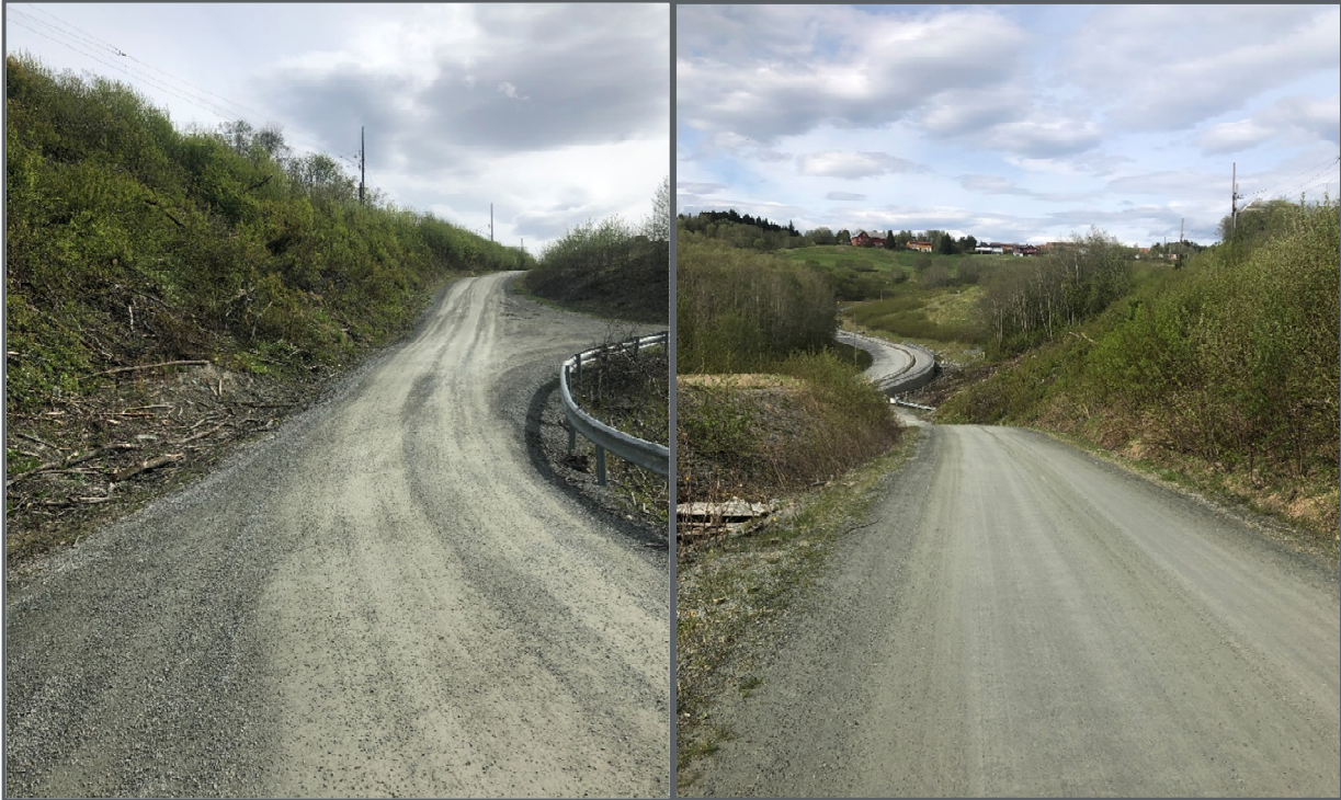
Figur 4: Nedre del av adkomstveg sett fra nord og fra sør.
