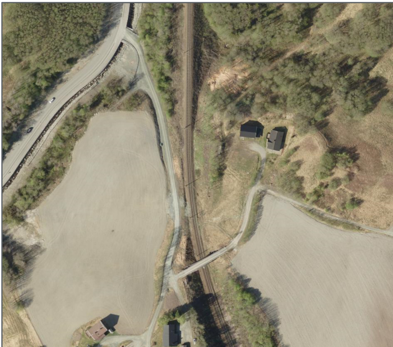
Figur 2: Adkomstveg med avkjørsel mot Heimdalsvegen etter utbedring i 2015.
