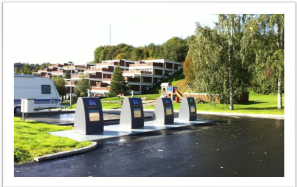
Figur 5 Nedgravde containere (Trondheim kommune).
