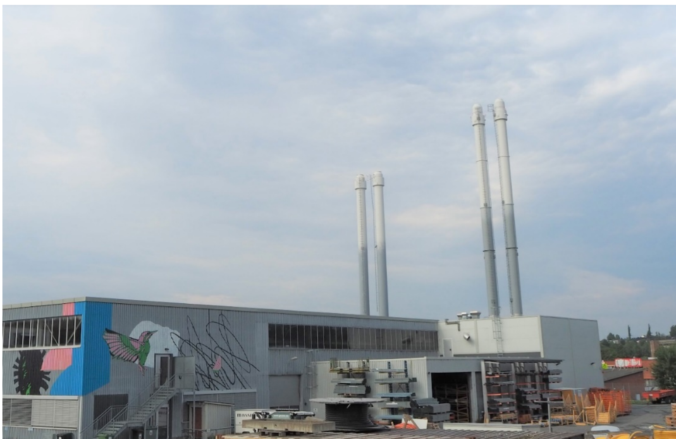
Figur 13 Pipene til varmesentralen i Leirfossvegen
