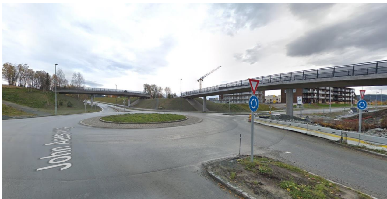
Figur 7 Nyanlagt rundkjøring i John Aaes veg i 2016
