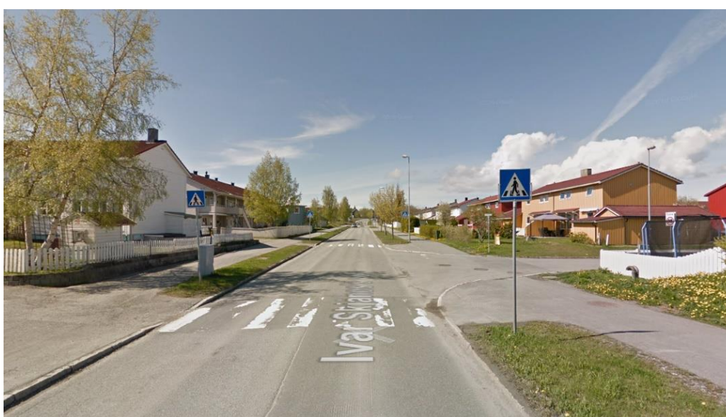
Figur 9 Adskilt gang- og sykkelveg og bilveg i Ivar Skjånes's veg
