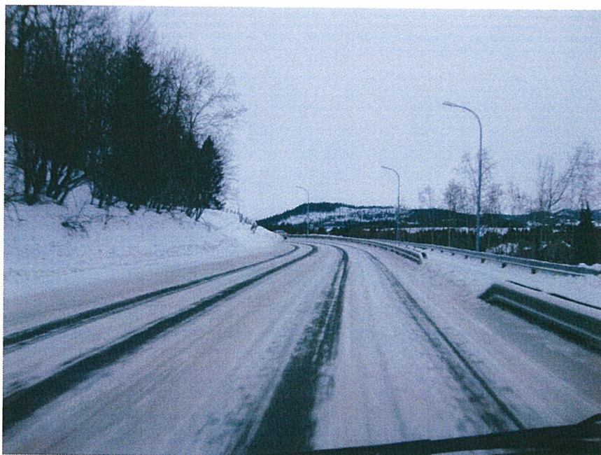
Dårlig sikt rundt svingen ved kryssingsstedet
