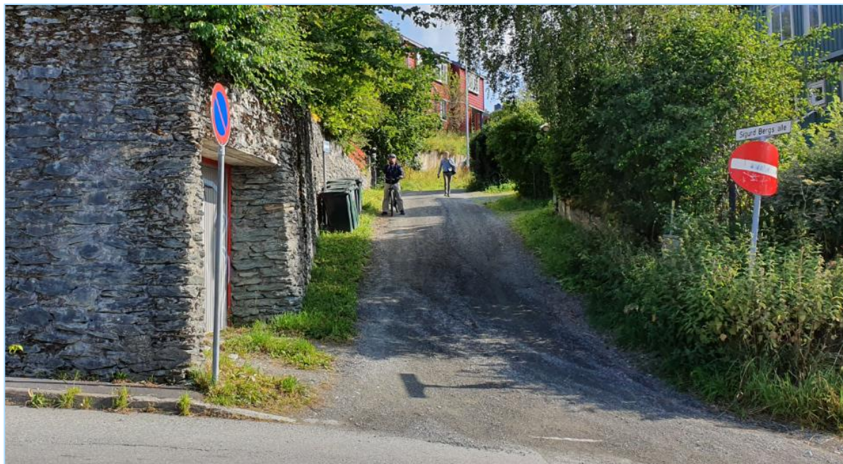
Figur 26 Eksisterende situasjon i krysset Weidemanns vei X Sigurd Bergs allé
