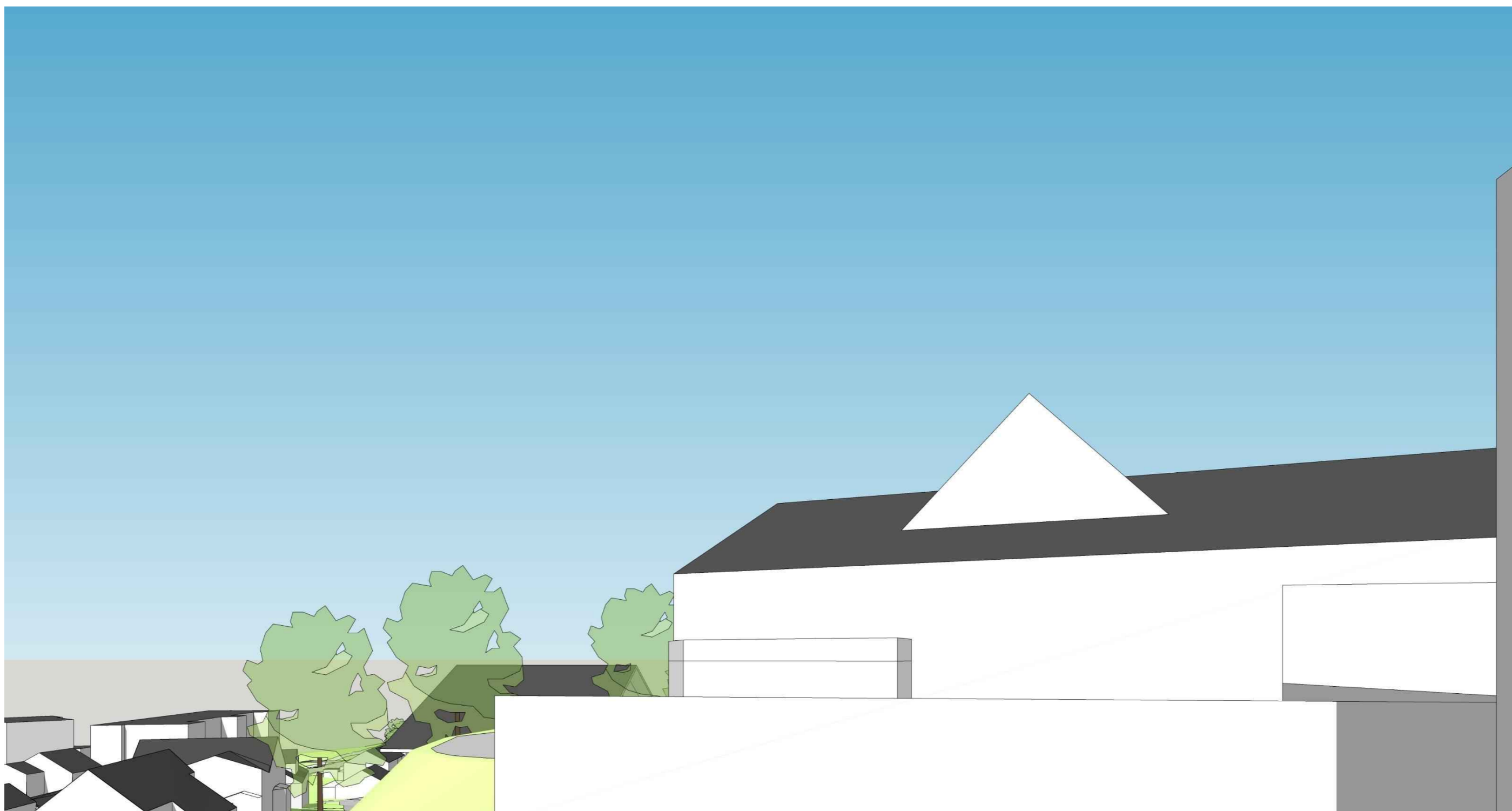
37/ Brit Grytbaks veg 24, terrasse mot NV, 2 av 2, dagens situasjon
