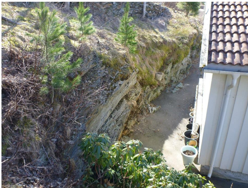
Foto 2: Eksisterende bergskjæring øst for Brit Grytbaks veg 20.
