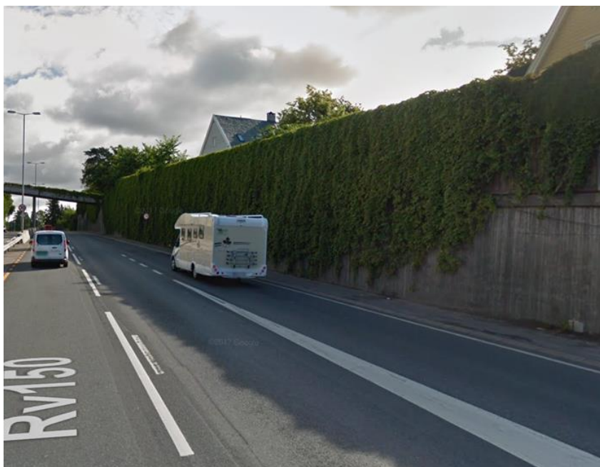
Foto 8: Fra Ring 3 i Oslo ved Smestad/Vinderen som viser støyskjerm og mur dekket av hengende klatreplanter [9].
