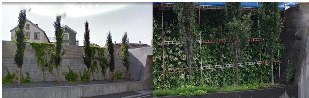
Foto 6: Eksempel på grønn «forblending» av mur langs Nordre Avlastningsveg ved IISvika i Trondheim, venstre bilde er tatt etter etablering [9] og bildet til høyre er i dagens situasjon.
