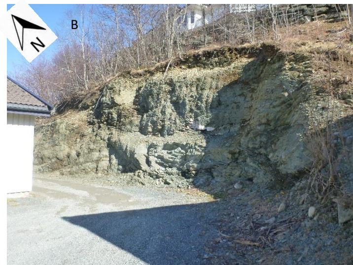
Foto 1 A, B: Eksisterende skjæring bak Brit Grytbaks veg 22A (gnr/bnr 47/12).
