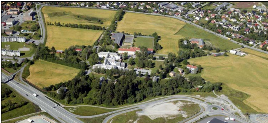
Figur 2: Flyfoto av Brøset i dagens situasjon
