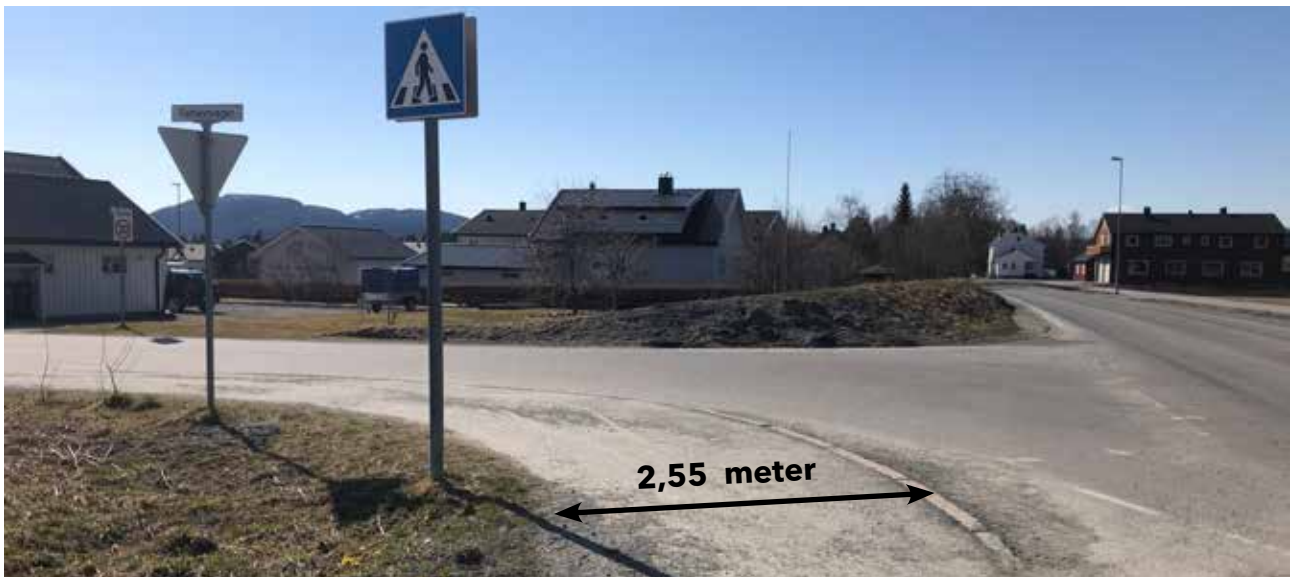
Flatheimvegen til venstre og fv 704 sett fra Nord: Når en krysser fv 704 kommer en over til Flatheimvegen. Her er fortauet 2.5 m med en 13 cm bred kantstein som er etter Trondheim kommunes norm.
