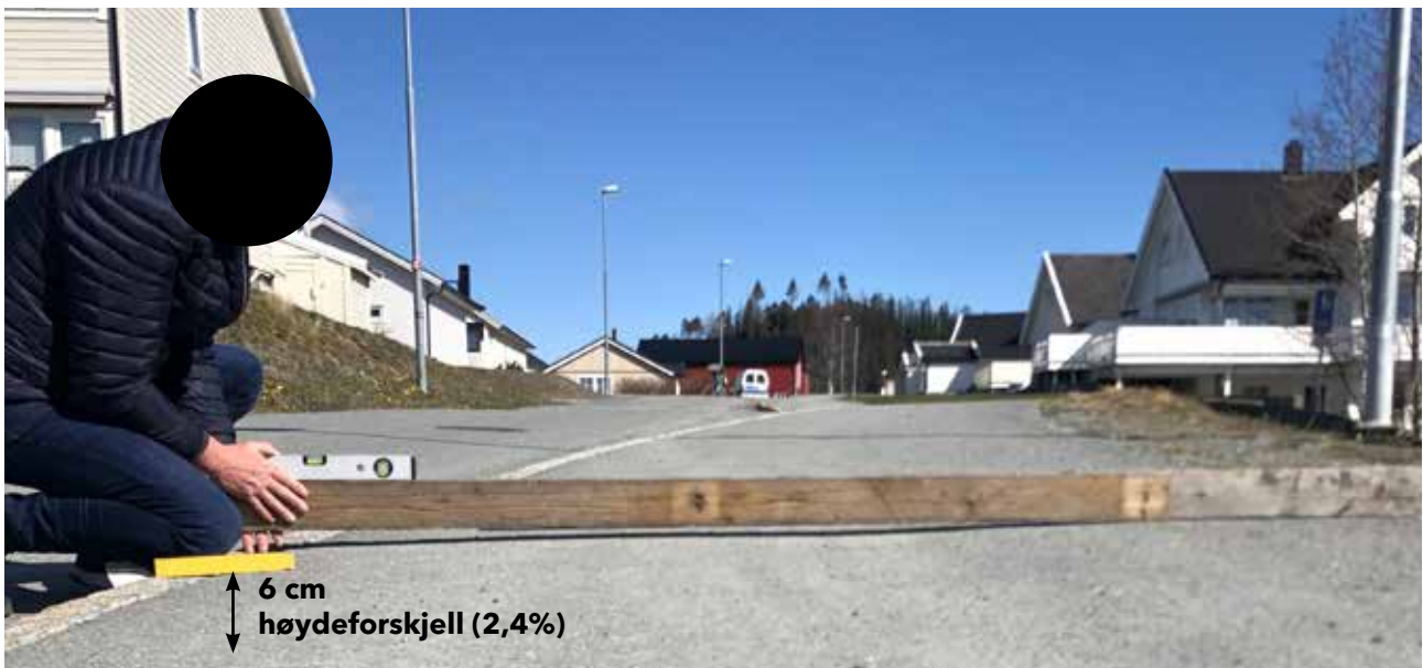
Flatheimvegen sett fra sør: Bildet viser fallforholdet i fortauet ved nordenden av planområdet ved målepunkt nr. 6
