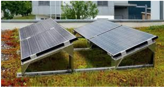
Figur 13: Løsning med solceller og grønt tak på samme takareal
