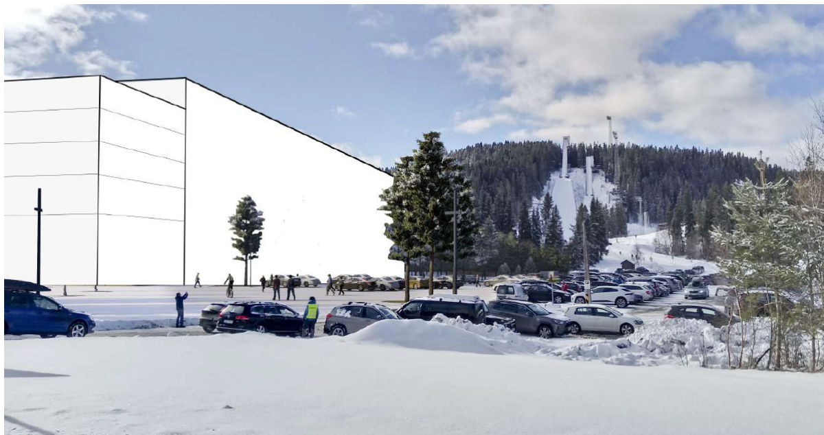
Over: Regulert volum av fotballhallen. Høyde reguleres til maks kote 200, og på frontpartiet 195. Bakken foran ved Kongsvegen er på ca kote 169. Vegetasjon på bildene er ikke sikret i bestemmelser.
