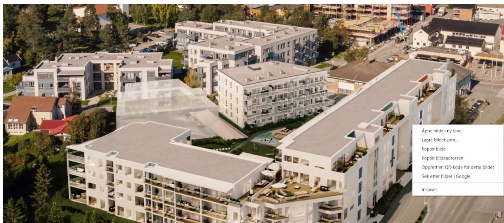
Nytt leilighetsprosjekt under oppføring i Kirkeringen 2. (Kilde: prosjekt.hem.no)
