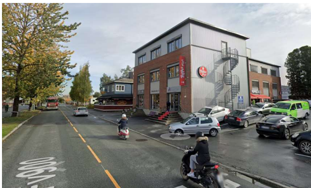
Framtidige kvartal burde i utgangspunktet ikke være for lange eller store, med spille på lag med stasjonsbyens mindre skala, og her er Heimdalsvegen nr. 4 et godt eksempel med sine tre etasjer og 16 meter brede fasade (kilde: google maps streetview, sept. 2020)
