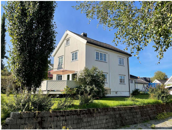
J.O.Stavs veg 11 (1950), Foreslått til verneklasse C. Typisk tomannsbolig fra 50-tallet som har fått nye vinduer med falske sprosser. Bør bevares av hensyn til bygningsmiljøet.
