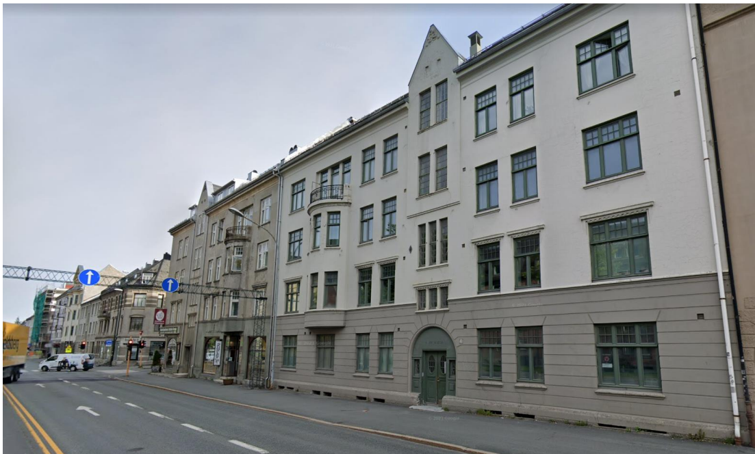
Figur 11: Murgårdene langs Elgeseter gate. Kilde: Google maps.
