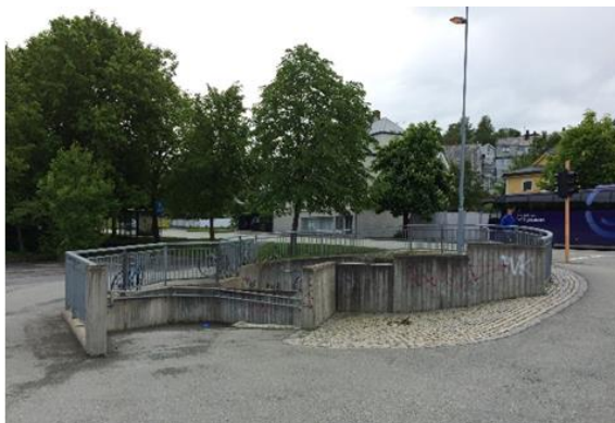
Til høyre: Eksisterende nedgang til undergang nord for Innherredsveien.
