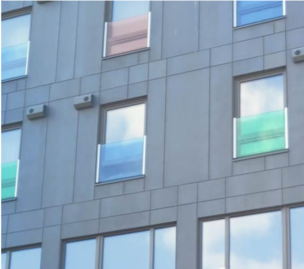
Figur 5-6 lavt eller høyt innovervendt luftvindu
