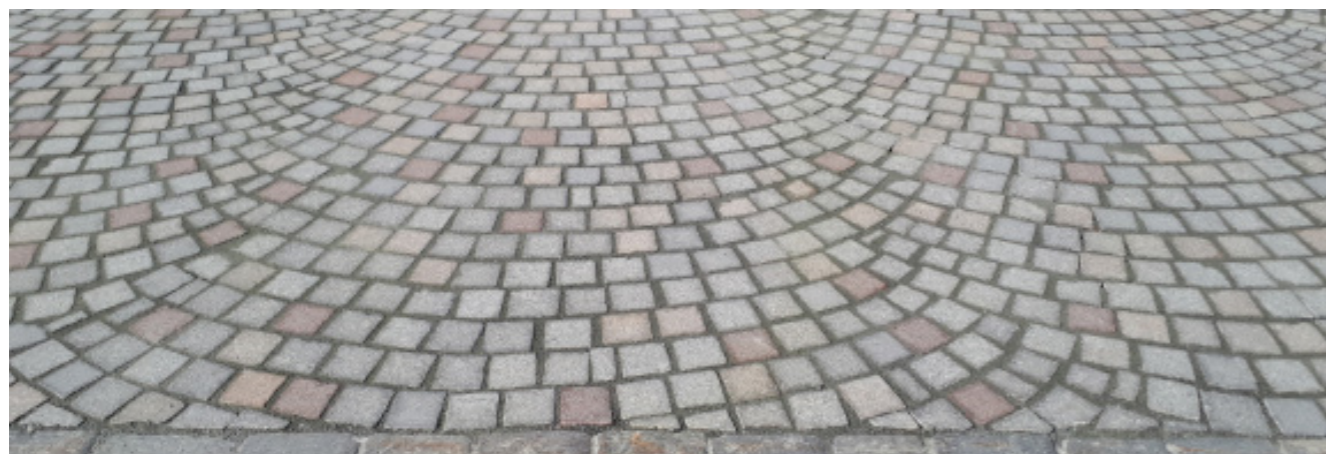
Ny saget og flammet smågatestein lagt i wienermønster i Kongens gate vest, Trondheim.
