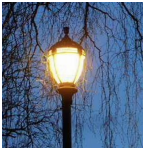
Den opale avskjermingen gjør at armaturen ikke fungerer bra lysteknikk
