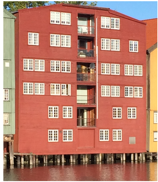
Kjøpmannsgaten 35 2014 mot elva
