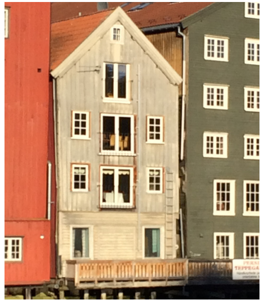
Kjøpmannsgaten 21 2014 mot elva
