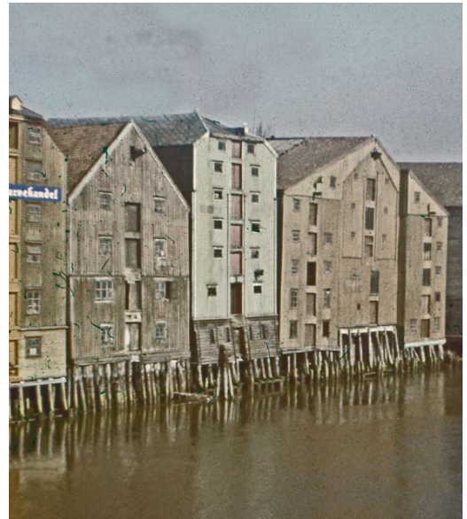
Kjøpmannsgaten 11 1954-1968 mot elva
