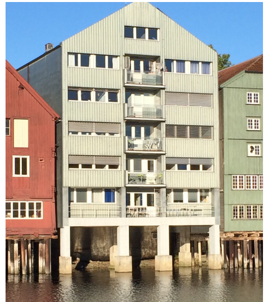
Kjøpmannsgaten 31 2014 mot elva
