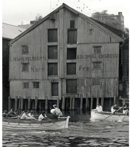
Kjøpmannsgaten 53-55 1967 mot elva
