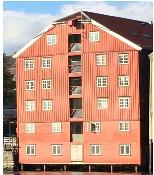
Kjøpmannsgaten 51 2014 mot elva
