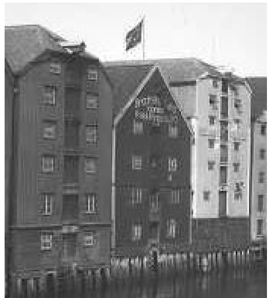
Kjøpmannsgaten 9 1914 mot elva
