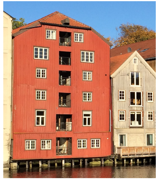
Kjøpmannsgaten 19 2014 mot elva
