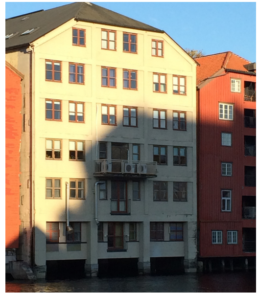
Kjøpmannsgaten 17 2014 mot elva
