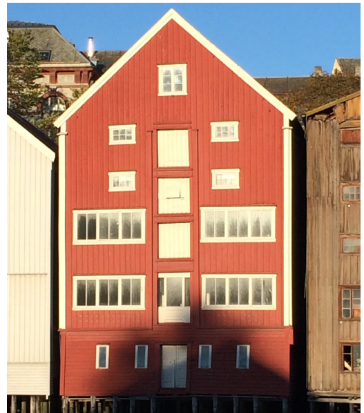
Kjøpmannsgaten 11 2014 mot elva
