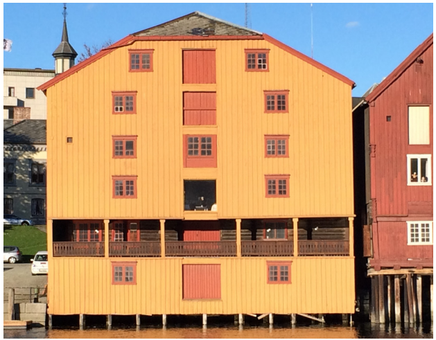
Kjøpmannsgaten 27 2014 mot elva
