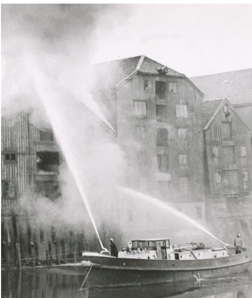
Kjøpmannsgaten 19, brann i nr. 17 1950 mot elva
