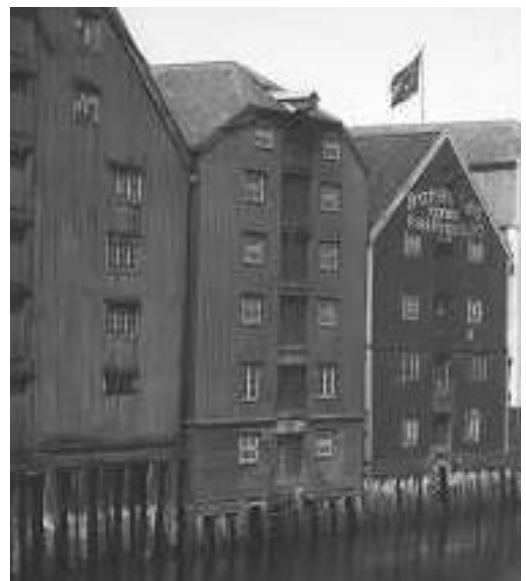
Kjøpmannsgaten 7 1914 mot elva
