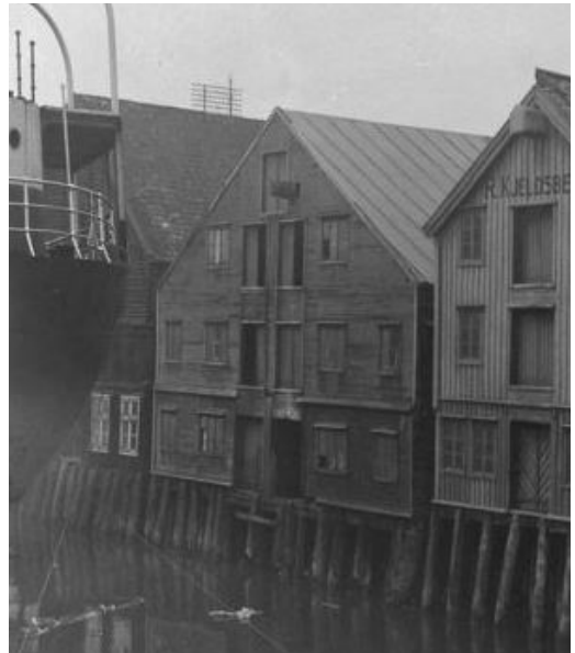
Kjøpmannsgaten 59 1941 mot elva
