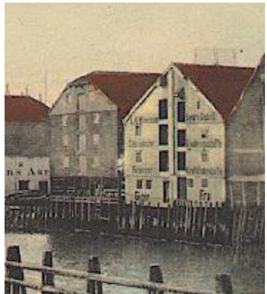
Kjøpmannsgaten 53-55 1901 mot elva
