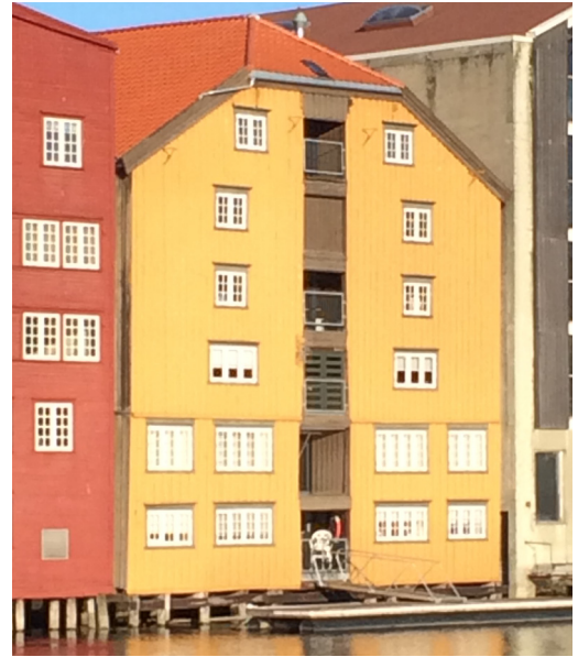
Kjøpmannsgaten 37 2014 mot elva
