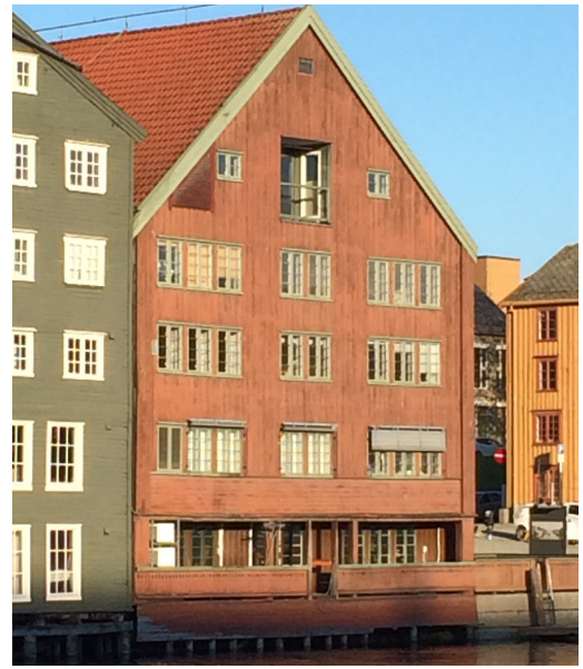
Kjøpmannsgaten 25 2014 mot elva
