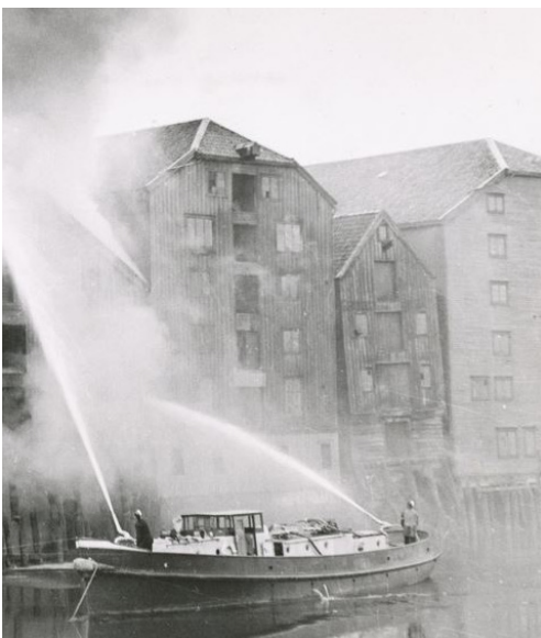
Kjøpmannsgaten 21, brann i nr. 17 1950 mot elva
