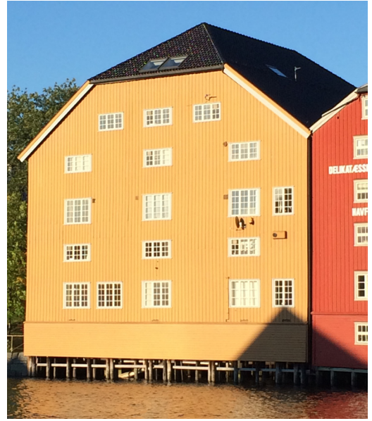
Kjøpmannsgaten 5 2014 mot elva
