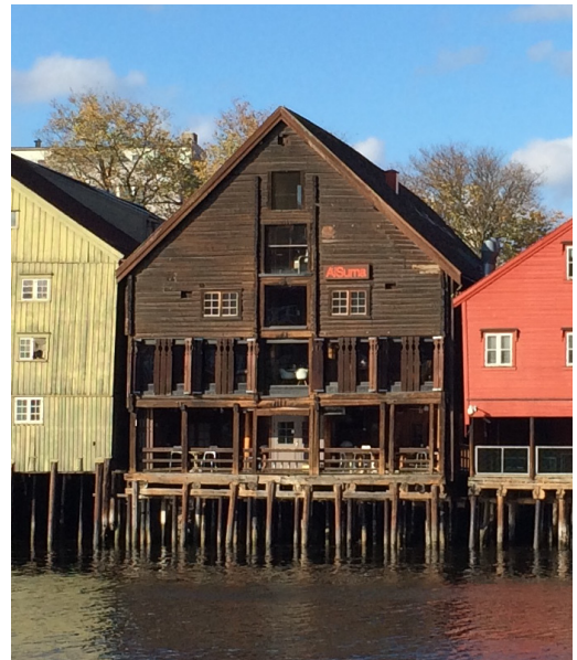
Kjøpmannsgaten 57 2014 mot elva
