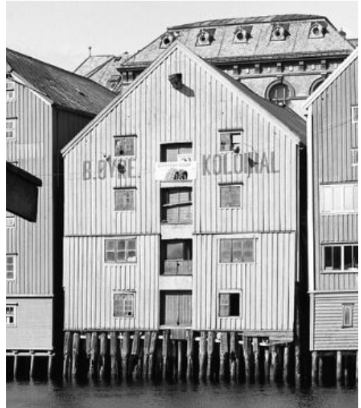
Kjøpmannsgaten 9 1972 mot elva
