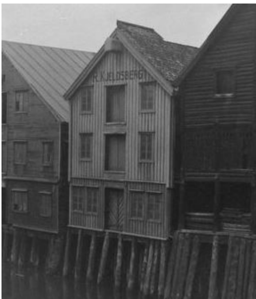
Kjøpmannsgaten 61 1941 mot elva
