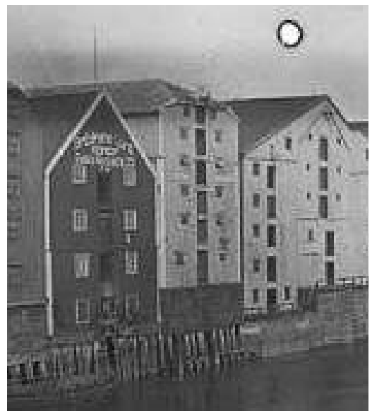
Kjøpmannsgaten 9 1906 mot elva
