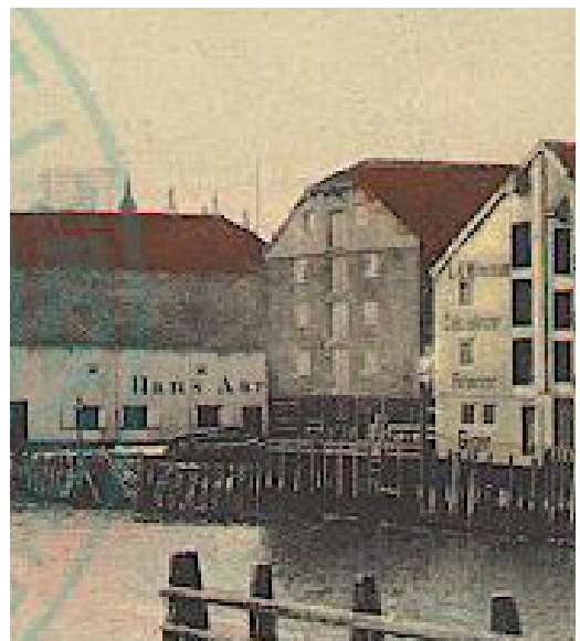
Kjøpmannsgaten 51 1901 mot elva
