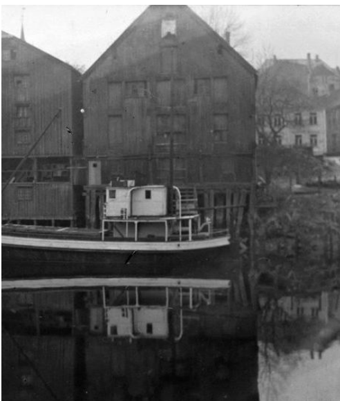
Kjøpmannsgaten 29 1945 mot elva
