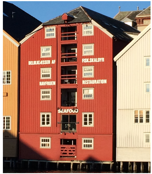
Kjøpmannsgaten 7 2014 mot elva
