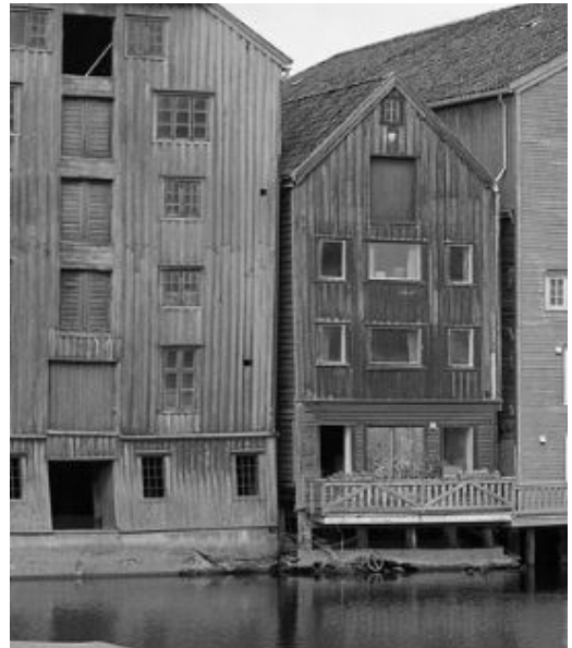
Kjøpmannsgaten 21 1972 mot elva
