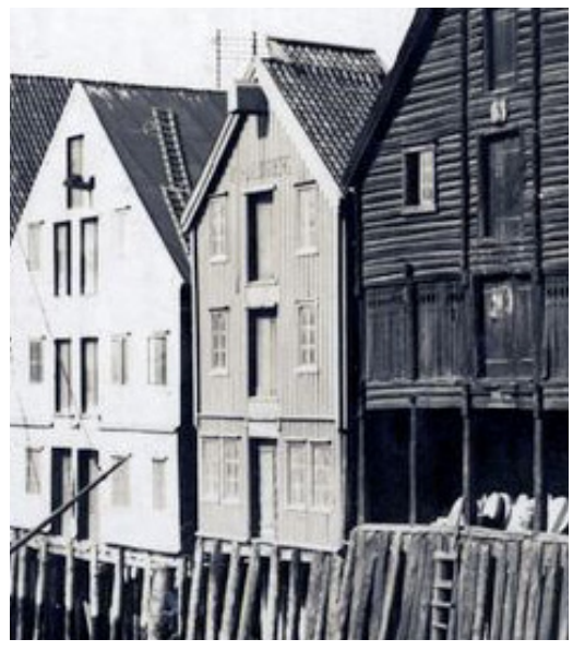
Kjøpmannsgaten 61 1915 mot elva
