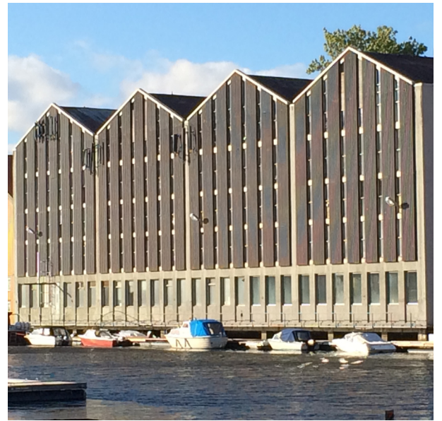
Kjøpmannsgaten 41 2014 mot elva
