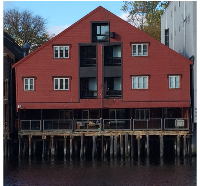
Kjøpmannsgaten 59 2014 mot elva
