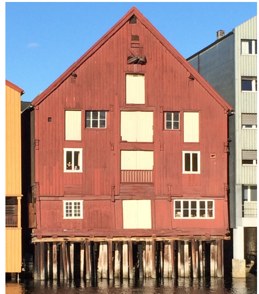
Kjøpmannsgaten 29 2014 mot elva
