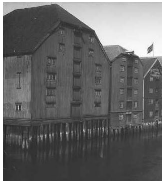
Kjøpmannsgaten 5 1914 mot elva
