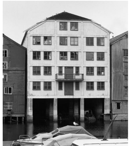
Kjøpmannsgaten 17 1972 mot elva
