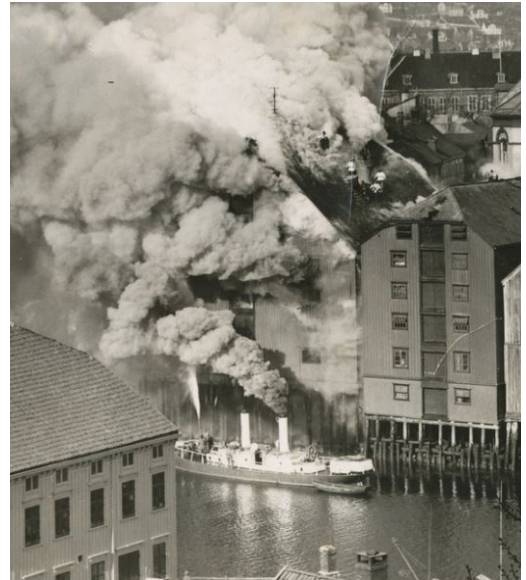
Kjøpmannsgaten 7, brann i nr. 5 1939 mot elva
