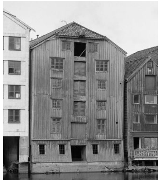
Kjøpmannsgaten 19 1972 mot elva
