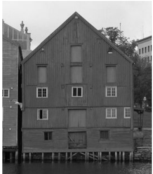
Kjøpmannsgaten 25 1972 mot elva
