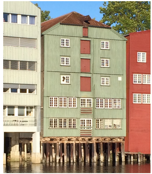
Kjøpmannsgaten 33 2014 mot elva
