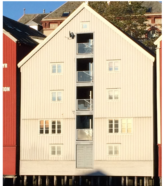
Kjøpmannsgaten 9 2014 mot elva
