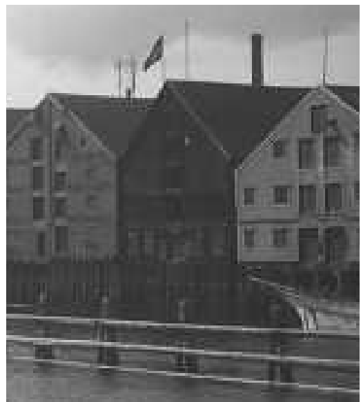
Kjøpmannsgaten 57 1914 mot elva
