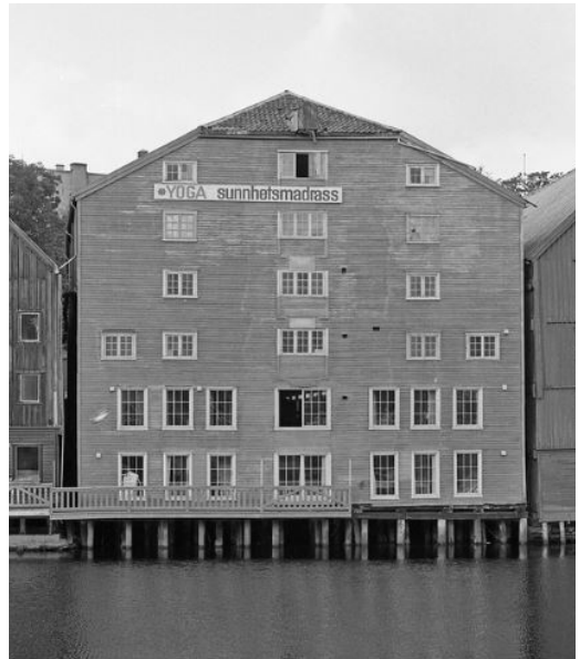
Kjøpmannsgaten 23 1972 mot elva
