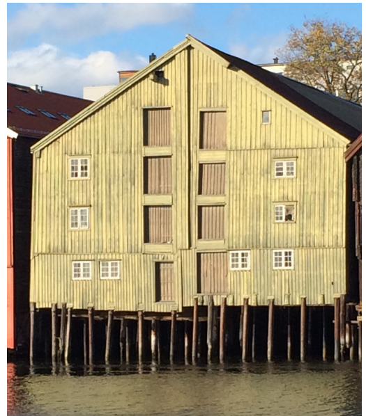
Kjøpmannsgaten 53-55 2014 mot elva
