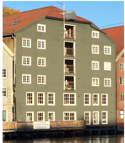
Kjøpmannsgaten 23 2014 mot elva
