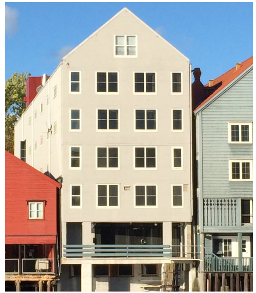
Kjøpmannsgaten 61 2014 mot elva
