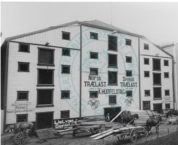
Kjøpmannsgaten 13, trelasthandel 1900-1906 mot Kjøpmannsgata
