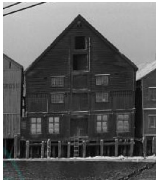
Kjøpmannsgaten 57 1960 mot elva
