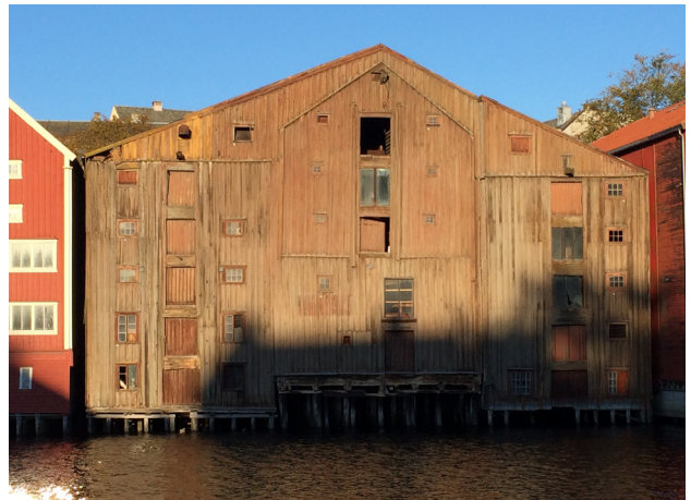
Kjøpmannsgaten 13 2014 mot elva
