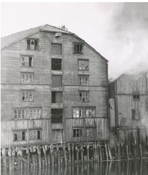
Kjøpmannsgaten 15, brann i nr. 17 1950 mot elva
