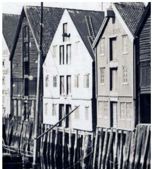
Kjøpmannsgaten 59 1915 mot elva
