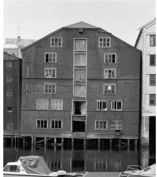
Kjøpmannsgaten 15 1972 mot elva
