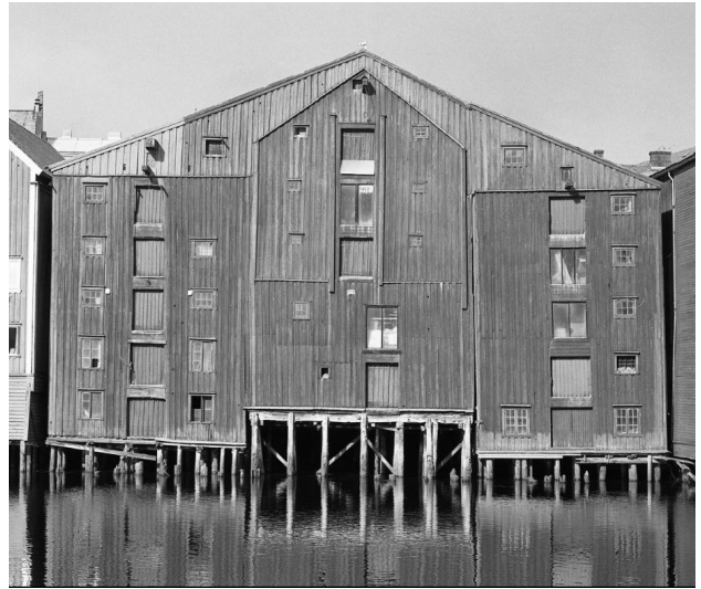
Kjøpmannsgaten 13 1972 mot elva
