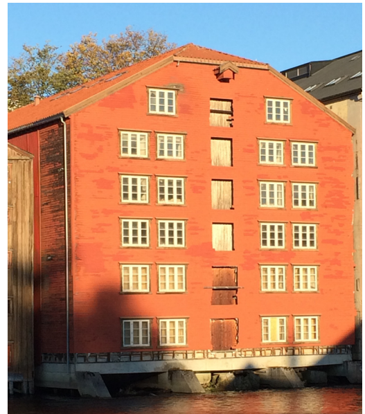
Kjøpmannsgaten 15 2014 mot elva
